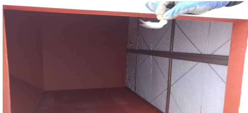
Hình 3.8. Hình dạng của khung vật liệu lọc pre-filter (tấm lọc G4)
