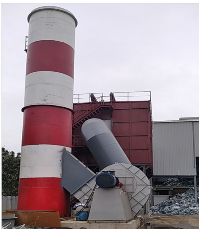
Hình 3.8. Thiết bị xử lý khói bụi sử dụng công nghệ túi lọc
