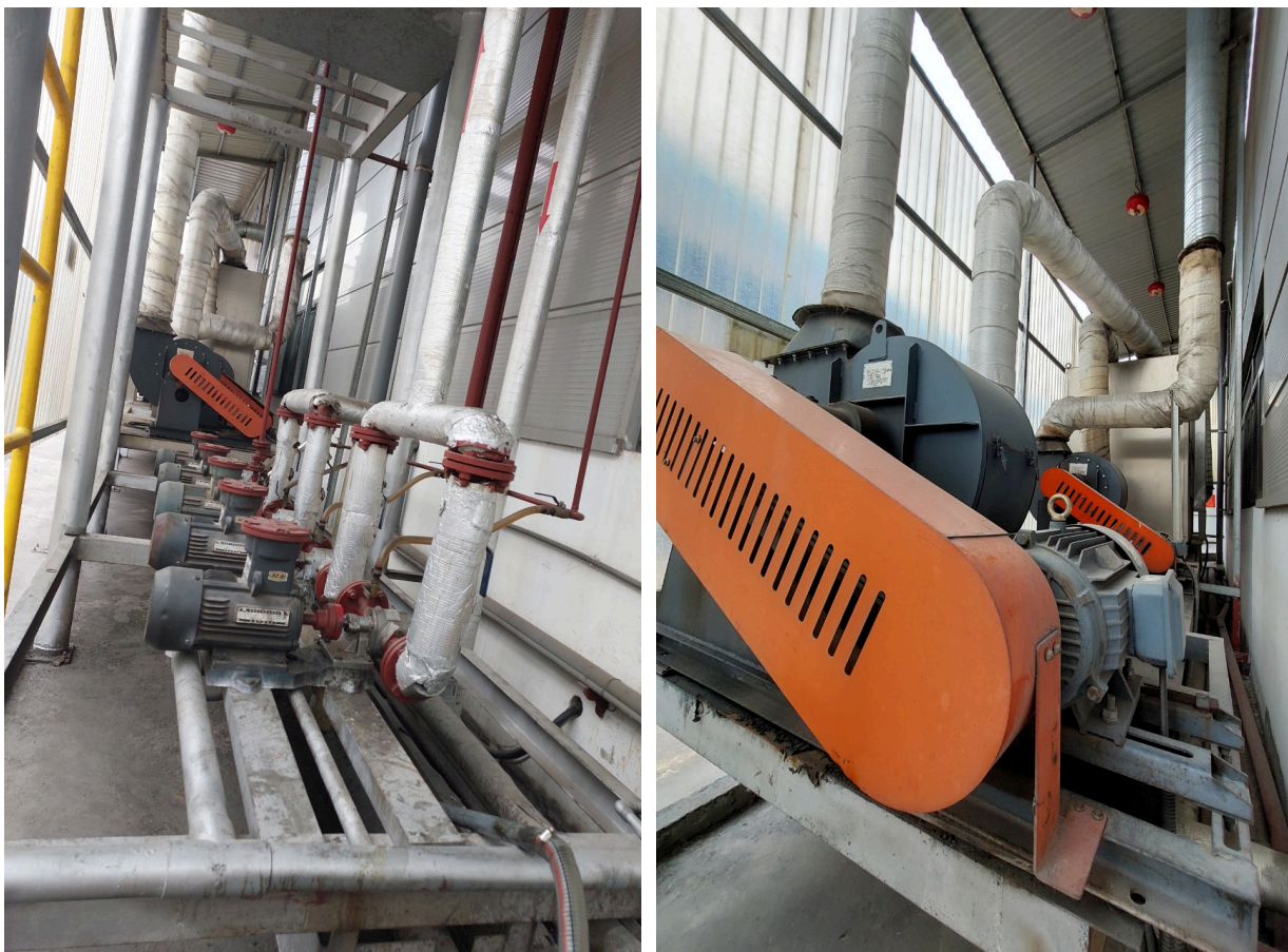
Hình 3.8. Hệ thống thu gom hơi sơn xưởng 22, 23, 25
