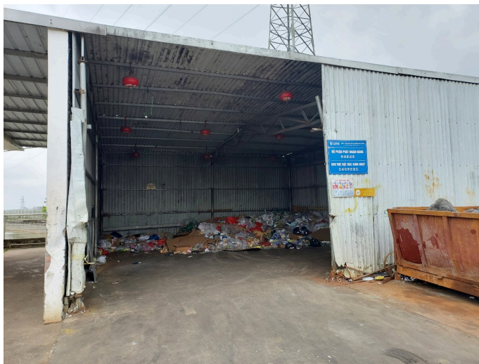
Hình 3. 12. Khu vực chứa chất thải sinh hoạt
