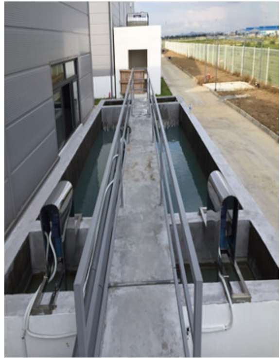
Hình 3.6. Hệ thống xử lý nước thải sản xuất công suất 100 m 3 /ngày đêm
