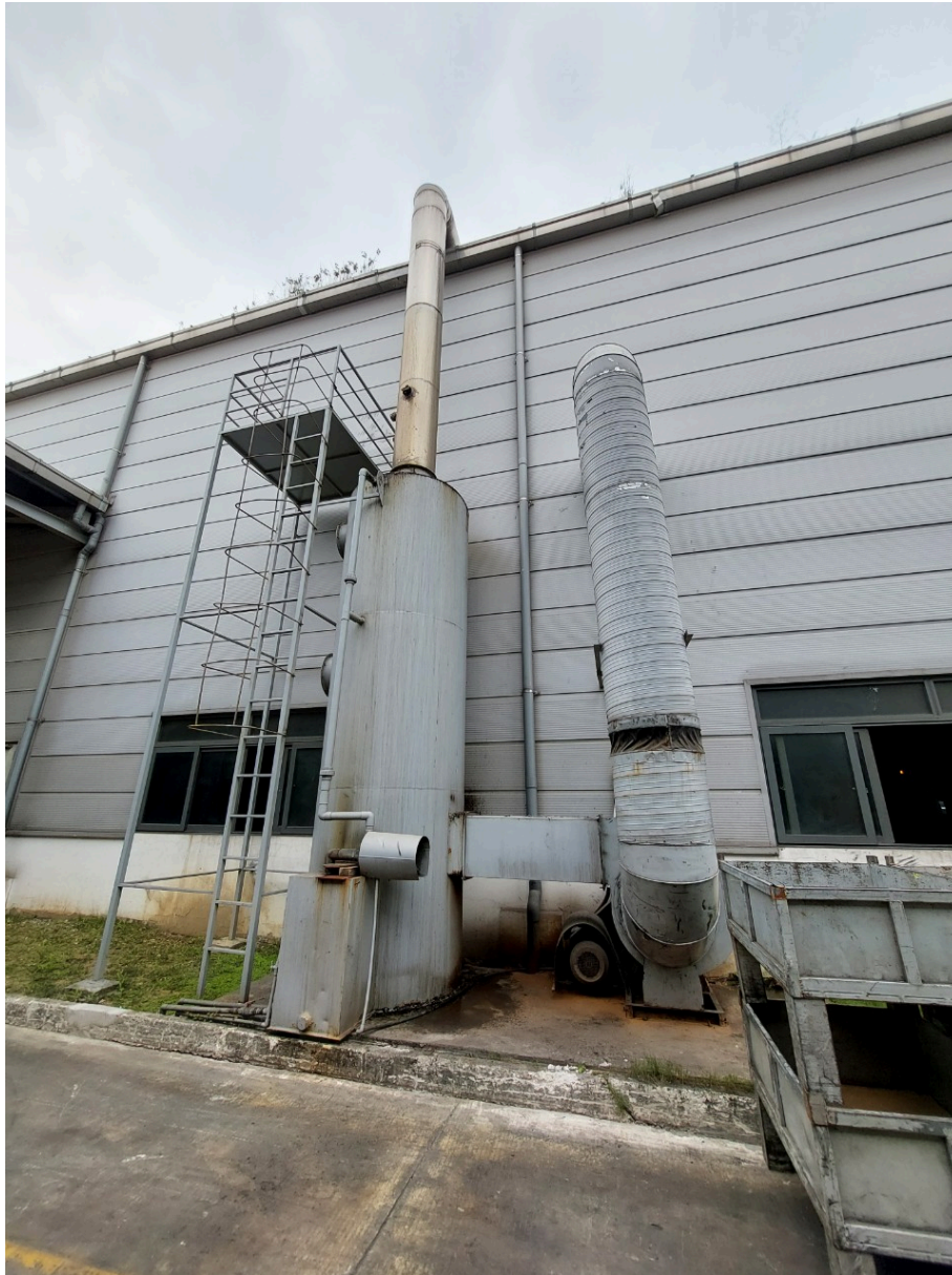
Hình 3.11. Hệ thống xử lý hơi Al xưởng 30
