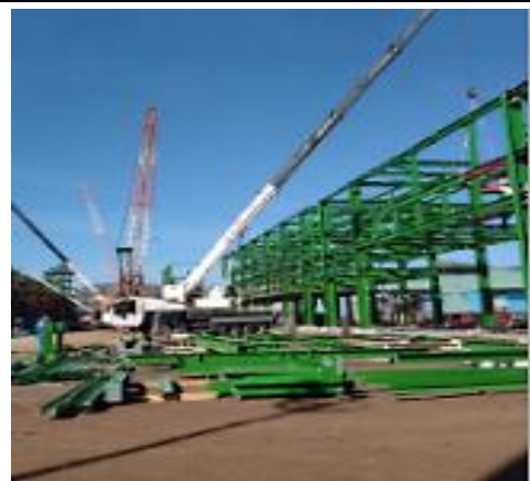
Hình 5. Lắp đặt các kết cấu khung chính
