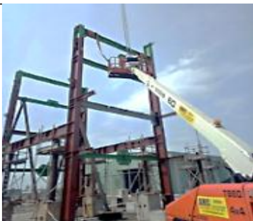
Hình 5. Lắp đặt các kết cấu khung chính
