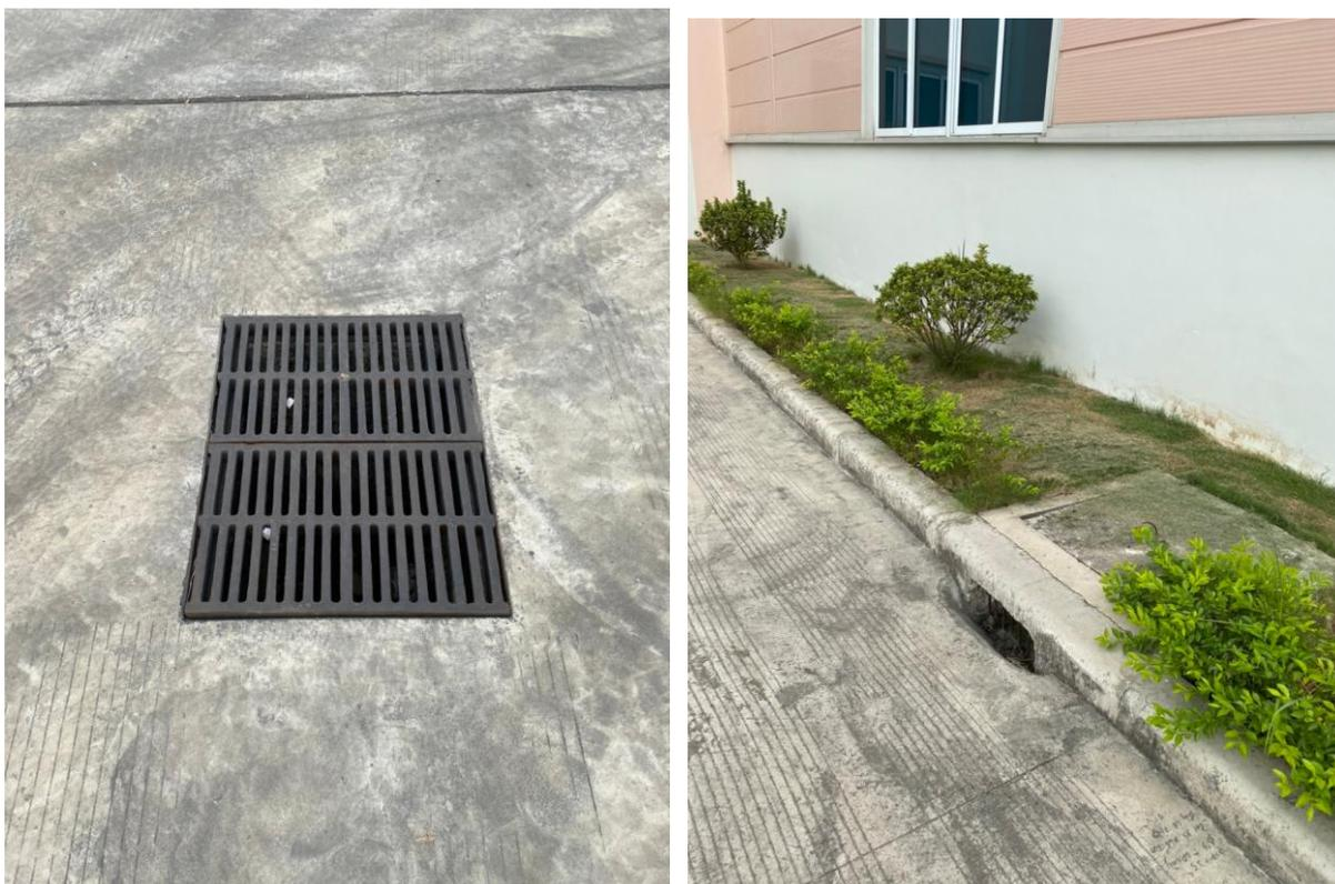
Hình 7. Hình ảnh hệ thống thu gom, thoát nước mưa của Dự án
