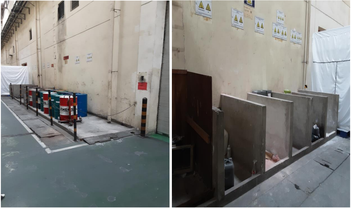
Hình 3.15. Công trình kho lưu chứa chất thải nguy hại
