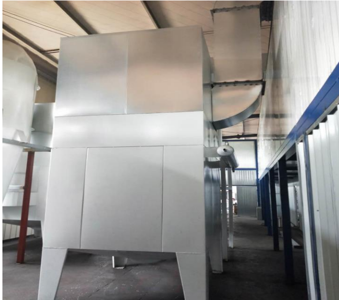
Bảng các thiết bị chính của hệ thống thu hồi sơn tĩnh điện:
