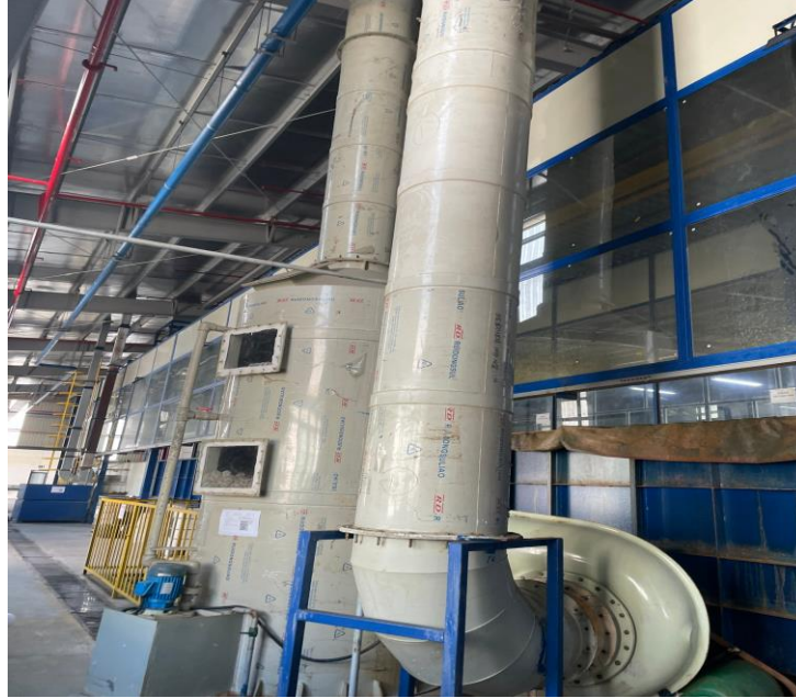
Hình ảnh tháp xử lý hơi axit đã lắp đặt:
