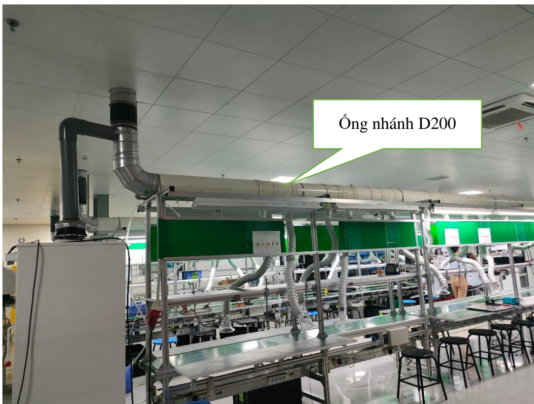
Hình 3.9. Hệ thống thu gom hơi kem hàn, hơi Sn, hơi keo
