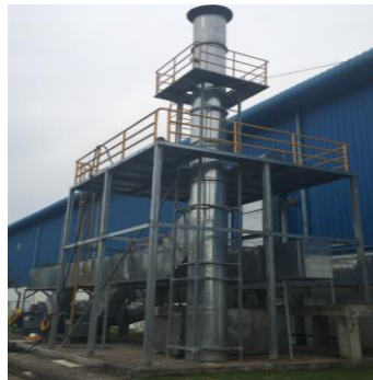
Hệ thống xử lý khí thải số 1
