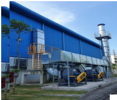
Hình 3.3. Hệ thống xử lý hơi thiếc hàn, hơi keokhi thải, hơi dung môi hiện có của dự án
