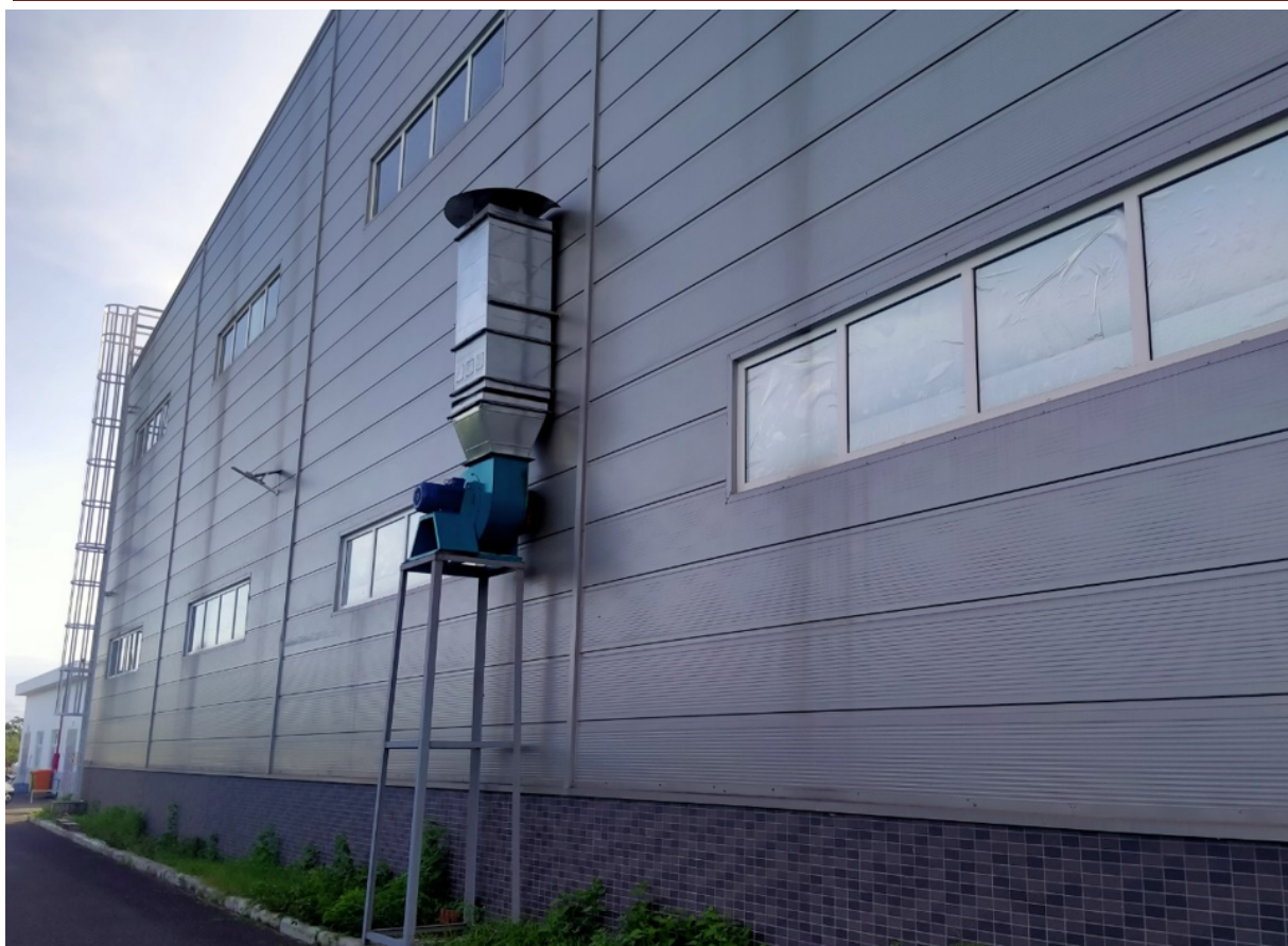
Hình 3.11. Hình ảnh ống thải của hệ thống xử lý khí thải từ khu vực in lụa
