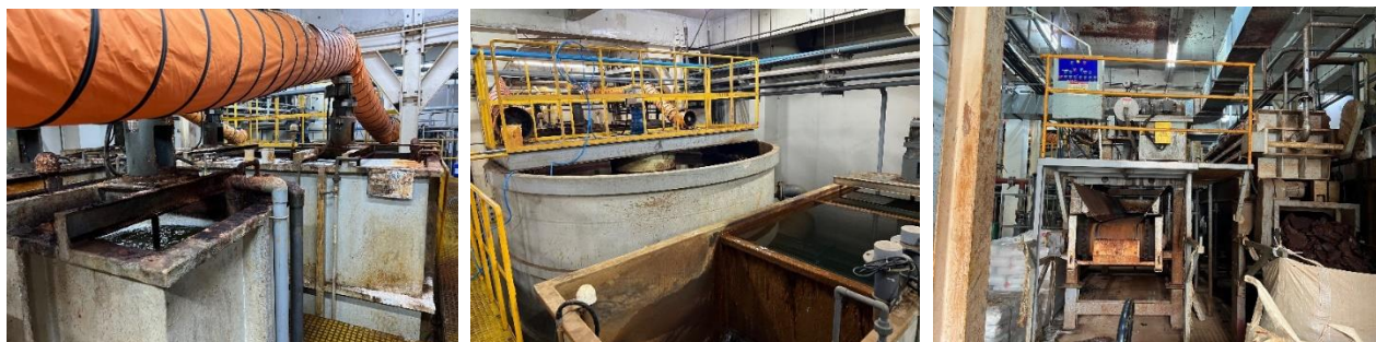
Hình 23. Hình ảnh hệ thống xử lý nước thải sản xuất 210 m 3 /ngđ
