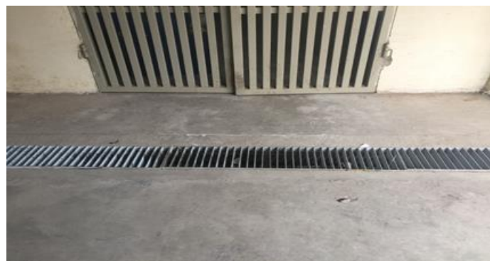
Hình 40. Hình ảnh kho chứa CTTT và kho CTNH của Nhà máy
