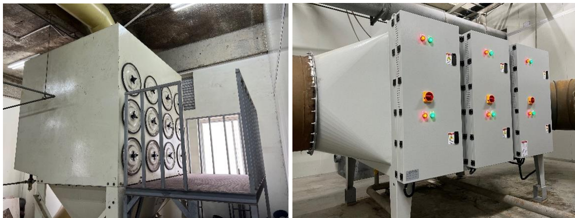
Hình 32. Hệ thống xử lý bụi khu vực sản xuất cuộn cảm in đa tầng – Nhà xưởng 1
