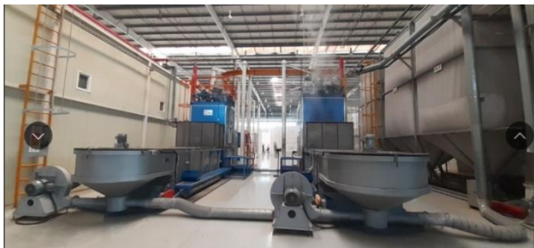
Công đoạn kích nổ
