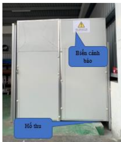
Kho chứa CTRCNTT của nhà máy 2 Kho chứa CTRCNTT tại nhà máy 3
