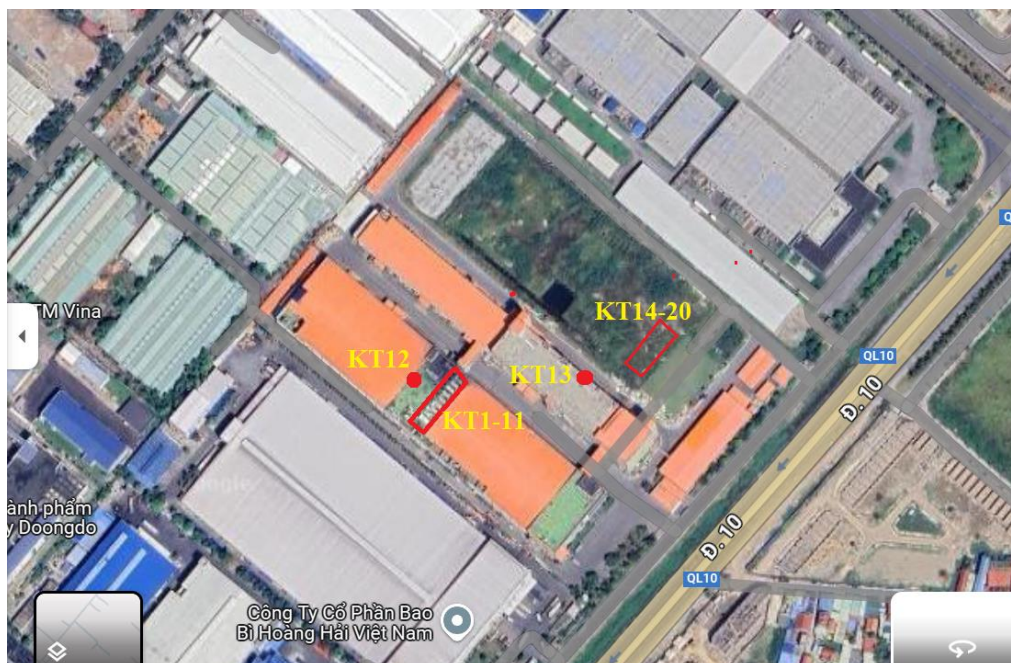
Hình 5.1. Vị trí quan trắc ống thoát khí định kỳ tại nhà máy 2
