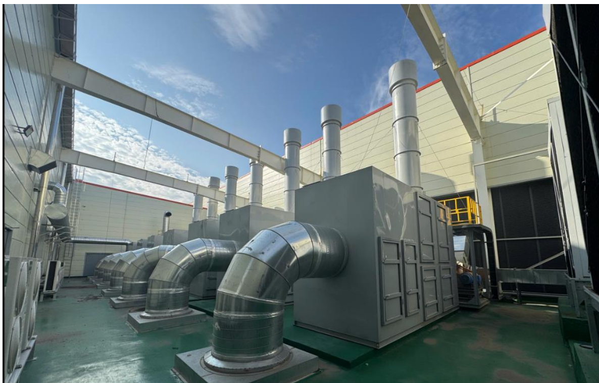
Hình 3.30. Hình ảnh 07 HTXLKT từ dây chuyền sơn tại nhà xưởng 04
