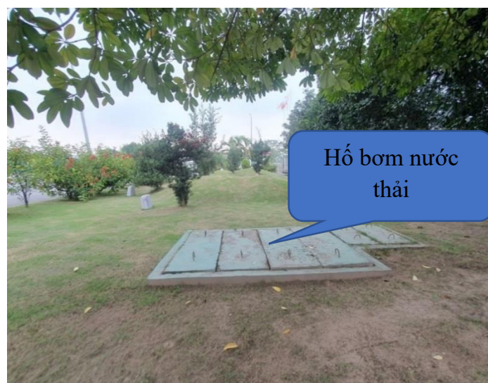
Hình 3.8a. Hình ảnh hố bơm nước thải, dung tích 3 m 3 tại Nhà máy 2
