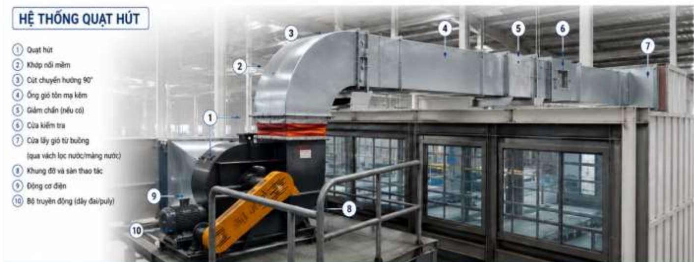
Hình 4.13. Hình ảnh mô phỏng hệ thống thu gom và xử lý khí thải phát sinh từ khu vực dây chuyền làm sạch bằng hoá chất (PT) và dây chuyền sơn điện di (ED)
