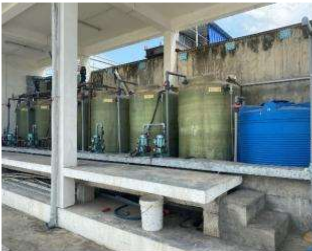
Bồn pha hóa chất keo tụ - tạo bông
