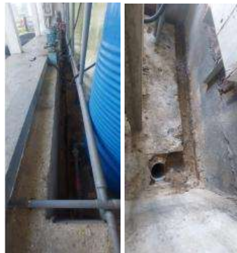
Gờ chống tràn hóa chất
