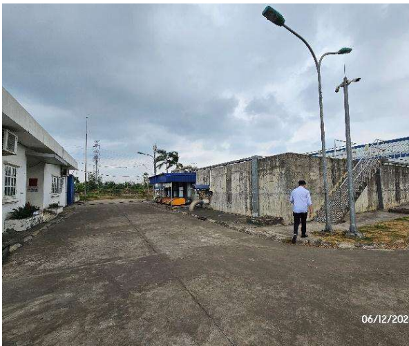
Khu vực trạm XLNT giai đoạn 1
