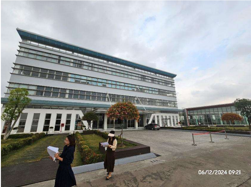
Khu nhà điều hành KCN
