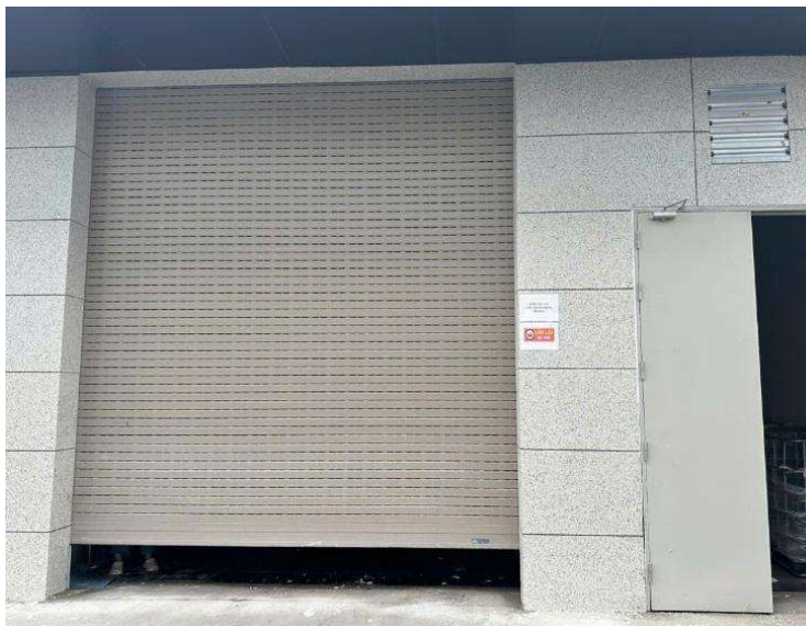
Hình 3. 32 – Hình ảnh thực tế kho chứa CTR công nghiệp thông thường
