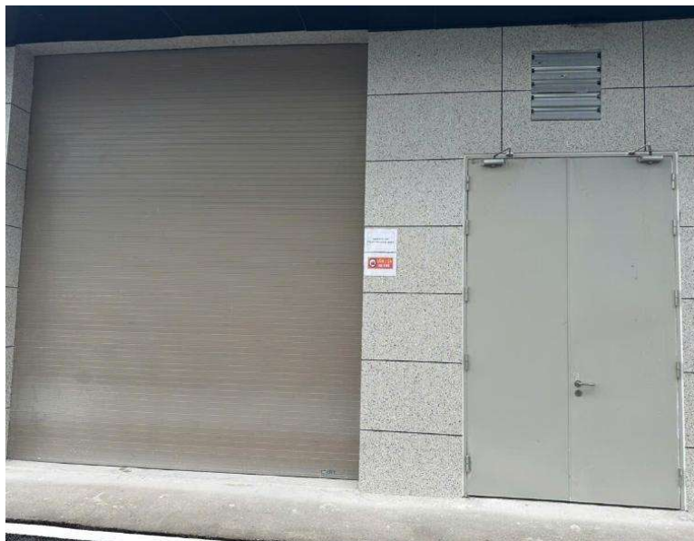
Hình 3. 31 – Hình ảnh kho chứa chất thải rắn sinh hoạt tại Dự án
