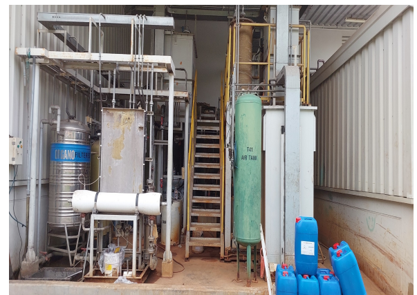
Hệ thống XLNT sản xuất, Q = 5 m 3 /ngày
