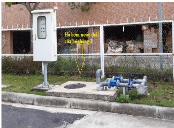
Hồ bơm nước thải
