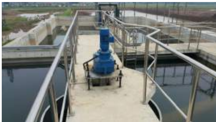
Bể lắng hóa lý
