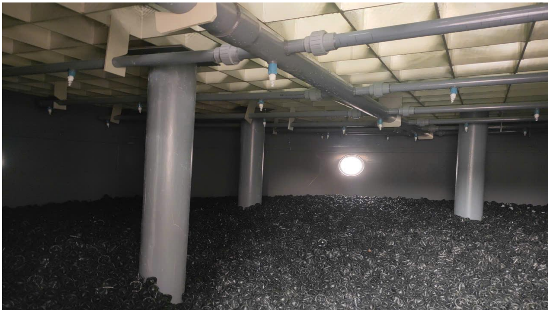
Bên trong tháp cải tiến thêm 3 dàn phun nước (bổ sung vật liệu bóng tăng khả năng tiếp xúc giữa khí và dung dịch)
