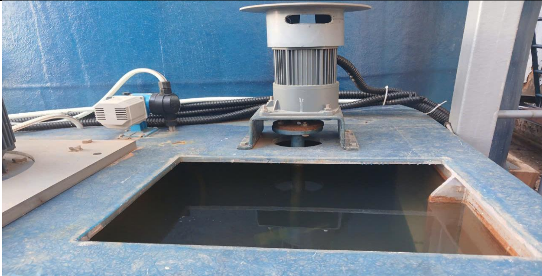
Bổ sung thêm NaOH để xử lý khí axit đảm bảo triệt để, tốt hơn.
