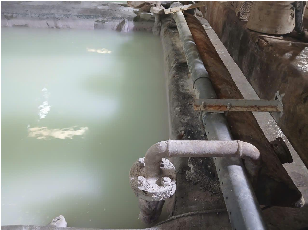
Lắp đặt hệ thống thổi khí miệng bể để thổi vào khu vực miệng chụp hút
