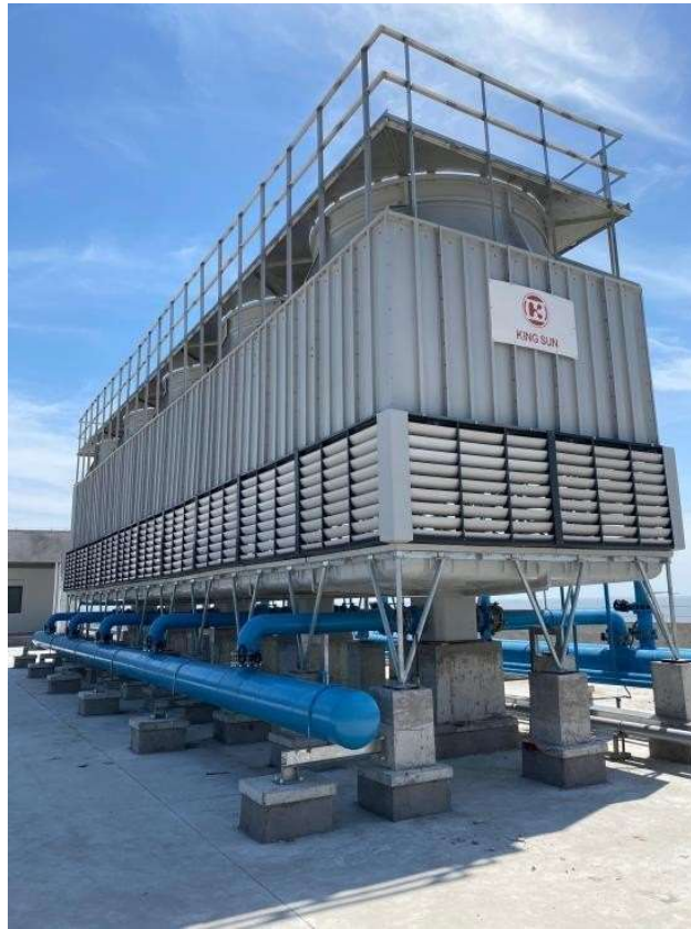
Hình 3. 9. Hình ảnh tháp giải nhiệt hiện hữu của cơ sở
