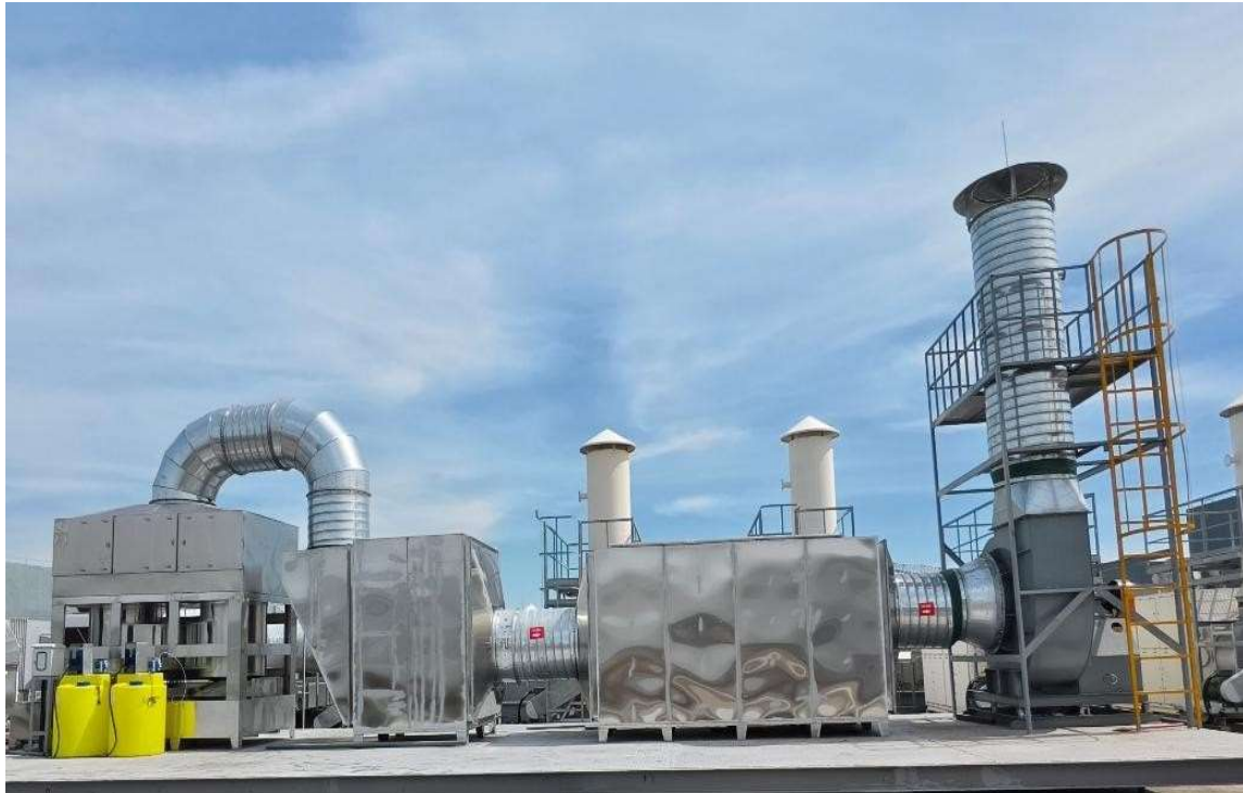
Hình 3. 29. Hệ thống xử lý khí thải HT22 (công suất 42.000 m 3 /giờ)
