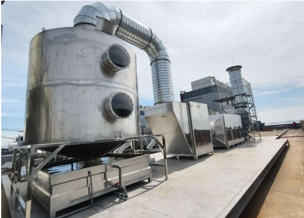
Hình 3. 32. Hệ thống xử lý khí thải HT23 (công suất 38.000 m 3 /giờ)
