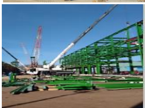
Hình 1.4. Lắp đặt các kết cấu khung chính
