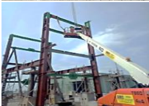
Hình 1.4. Lắp đặt các kết cấu khung chính
