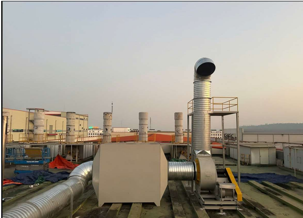
Hình 3.27. Hình ảnh HTXLKT từ 70 máy ép phun nhựa xưởng 01 địa điểm 02
