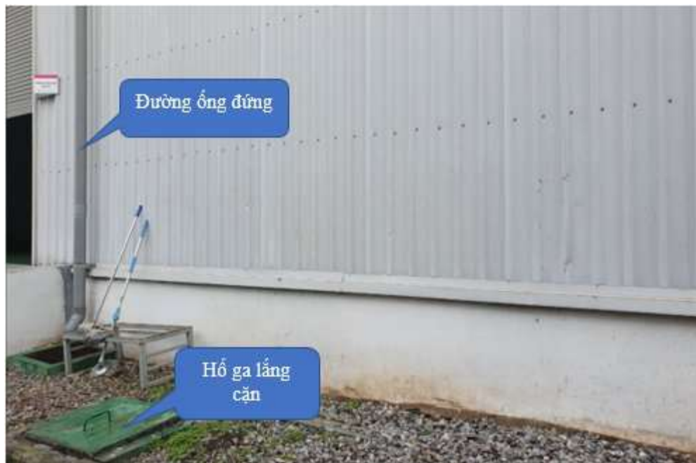
Hình 3.5. Hình ảnh hệ thống thu gom, thoát nước mưa tại địa điểm 03
