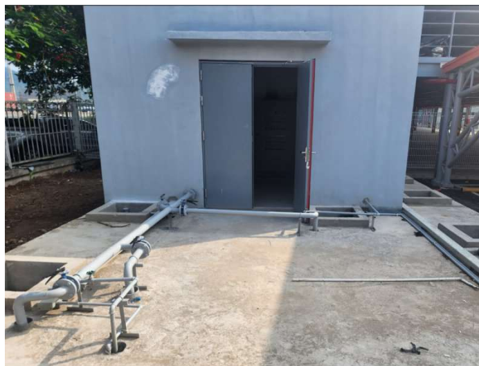
Nhà điều hành trạm xử lý
