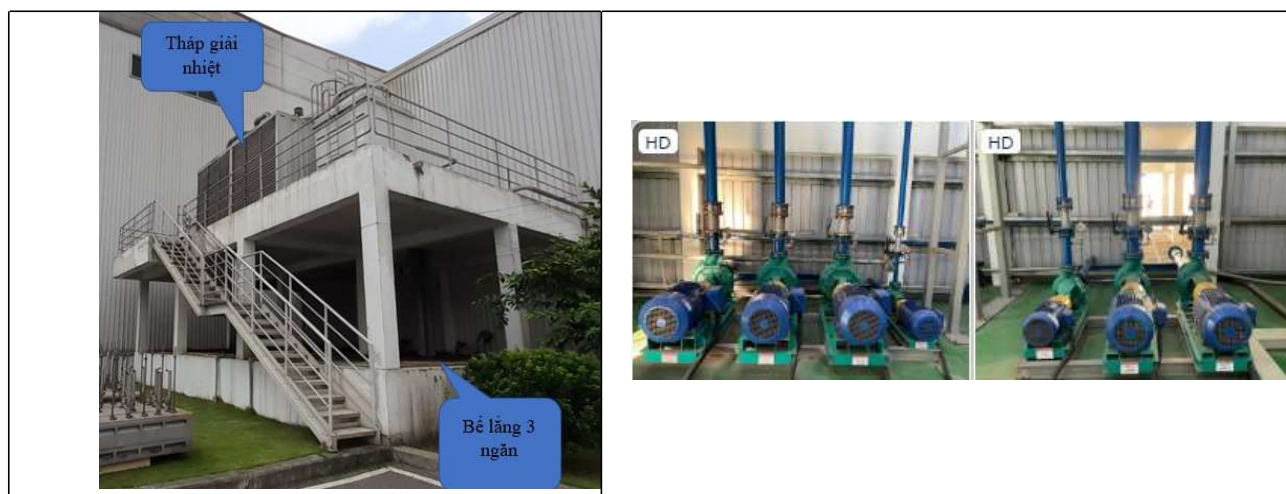
Hình 3.18. Hệ thống giải nhiệt nước làm mát bán thành phẩm xộp EPS, EPP tại địa điểm 03
