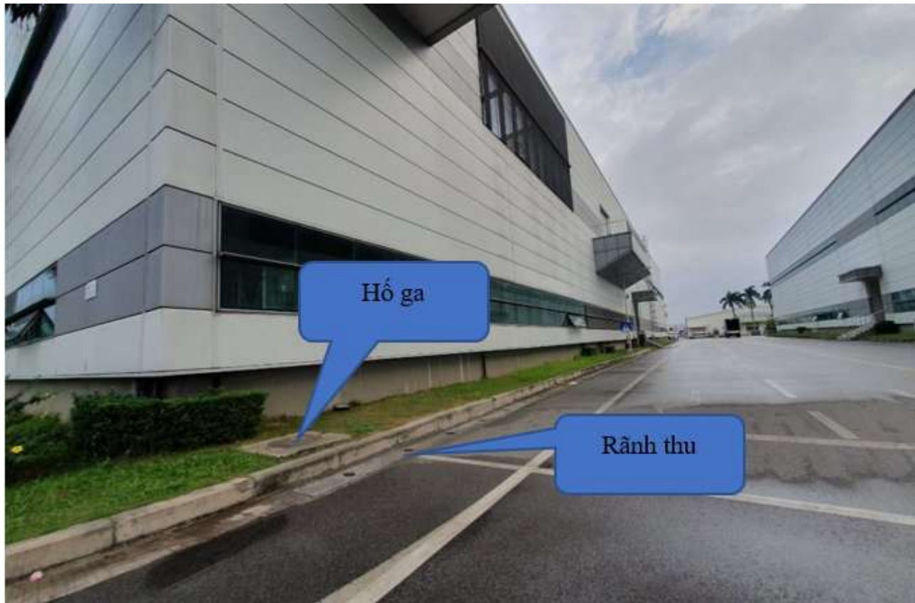
Hình 3.1. Hình ảnh công trình thu gom, thoát nước mưa tại địa điểm 01
