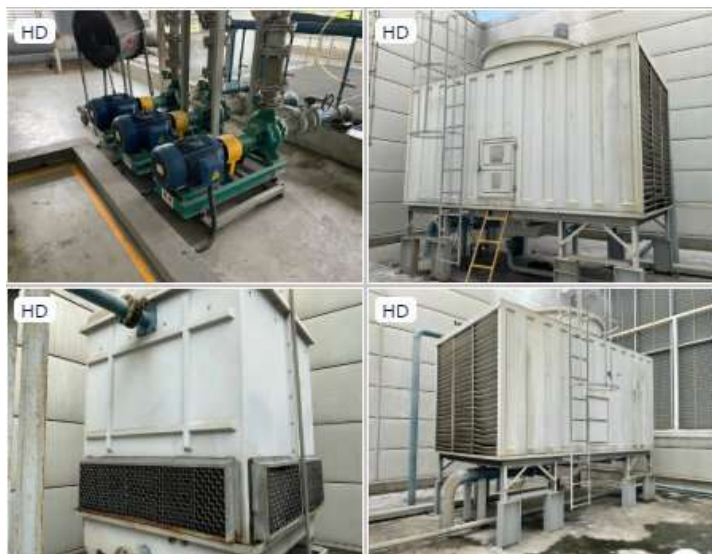
Hình 3.15. Hệ thống thu gom, giải nhiệt, tuần hoàn nước làm mát xốp EPS tại địa điểm 01
