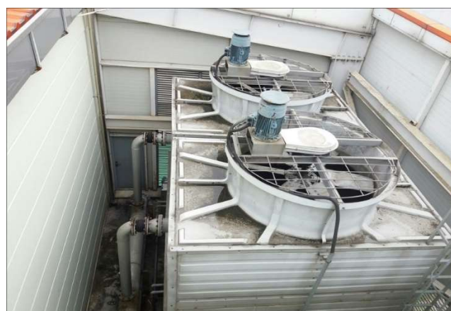
Hình 3.17. Hệ thống thu gom, giải nhiệt, tuần hoàn nước làm mát linh kiện nhựa tại xưởng 03 địa điểm 02
