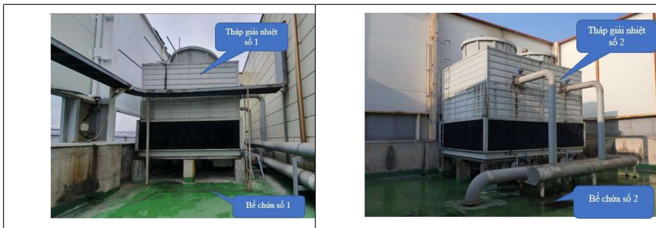
Hình 3.16. Hệ thống thu gom, giải nhiệt, tuần hoàn nước làm mát linh kiện nhựa tại xưởng 01 địa điểm 02
