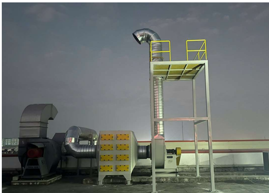
Hình 3.29. Hình ảnh HTXLKT từ 14 máy ép phun xưởng 03 (địa điểm 02)
