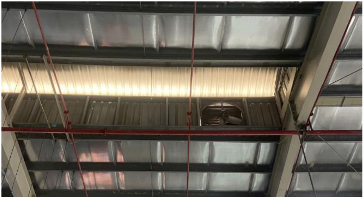
Hình 15. Thông gió nhà xưởng hiện trạng của Cơ sở
