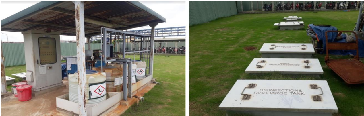
HTXL NTSH, công suất 35 m 3 /ngày đêm của NMI,2 và nhà xưởng 3.1
