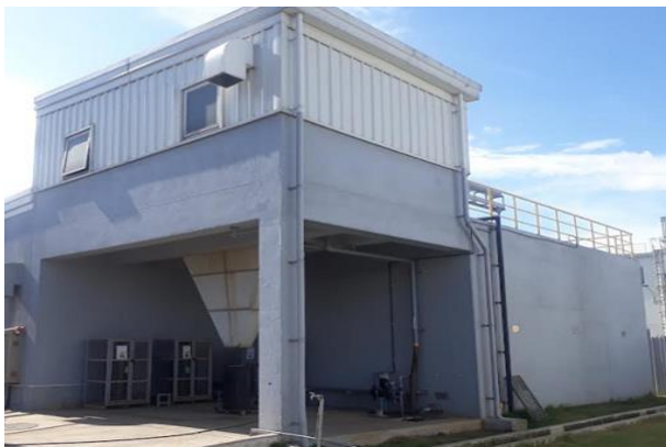
HTXL NTSH, công suất 135 m 3 /ngày đêm của nhà xưởng 4.1
