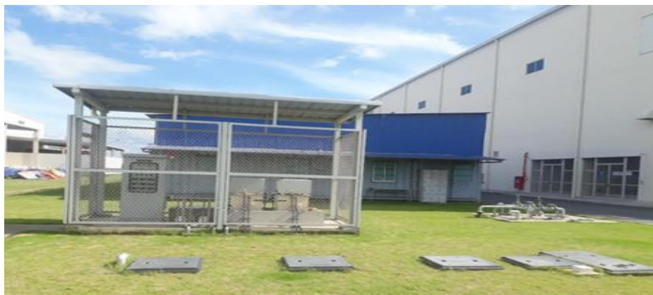
HTXL NTSH, công suất 7 m 3 /ngày đêm của NMI,2 và nhà xưởng 3.1
