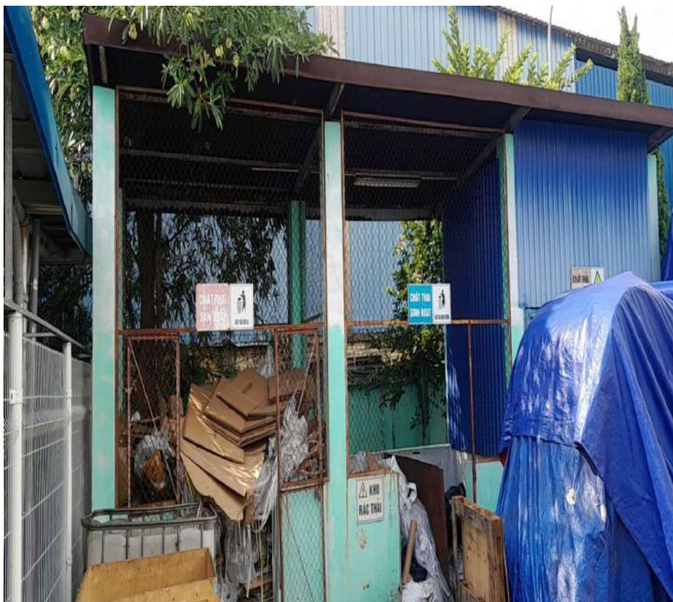
Hình 3.11. Hình ảnh kho chứa chất thải công nghiệp và chất thải sinh hoạt của công ty
