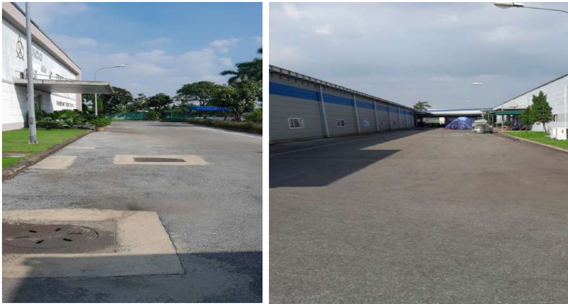
Hình 1.2. Hình ảnh hiện trạng khu vực sân đường nội bộ của nhà máy
