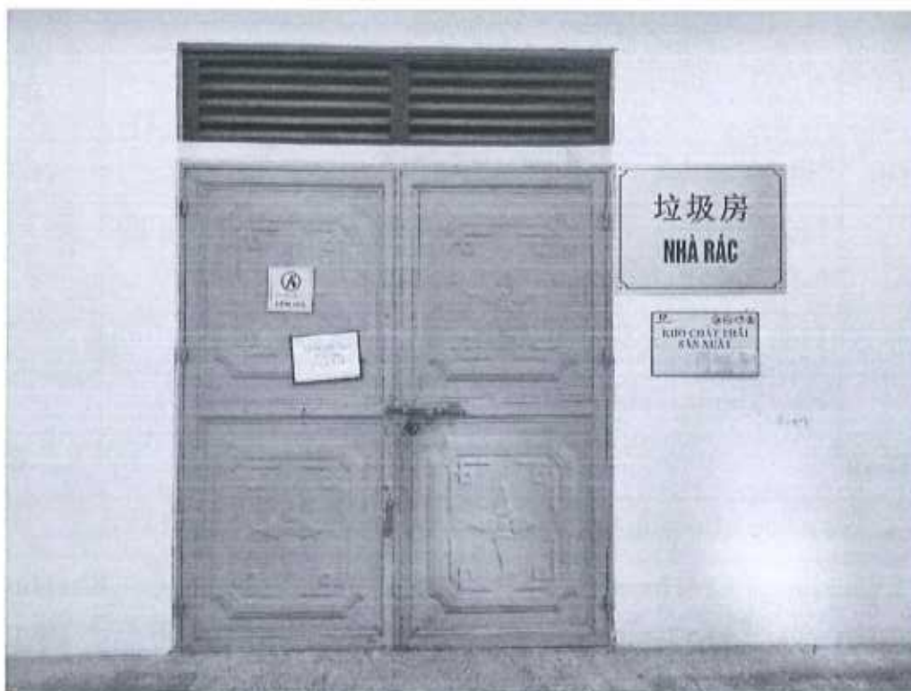
Hình 3.22. Nhà chứa rác thải công nghiệp thông thường
