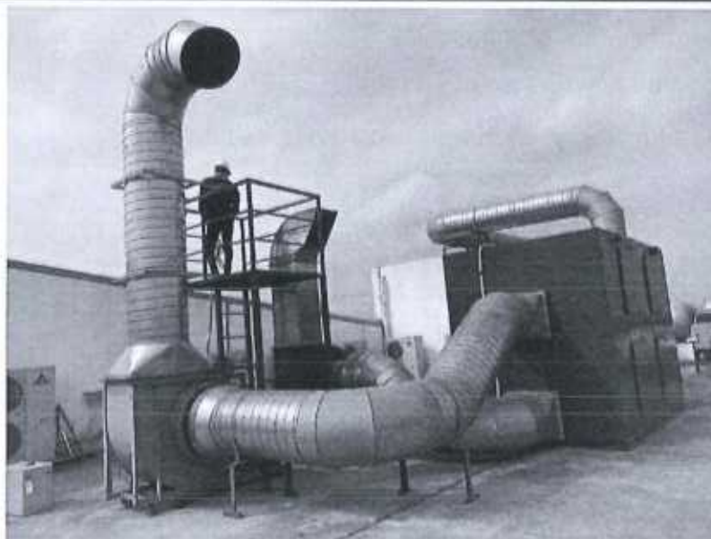
Hình 3.18. Hệ thống xử lý hơi mực in và hệ thống xử lý hơi hàn, hơi Sn, hơi keo e. Hệ thống xử lý bụi, hơi sơn
