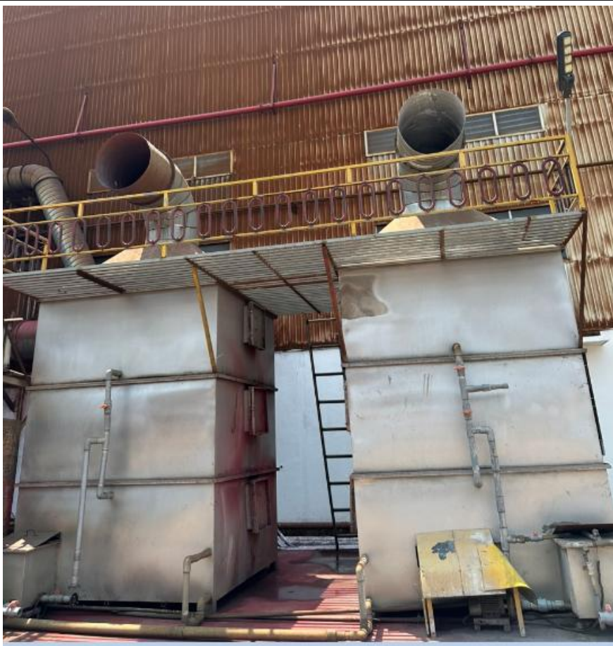
Hình 4.11. Hình ảnh minh họa hệ thống xử lý khí thải phòng sơn.
