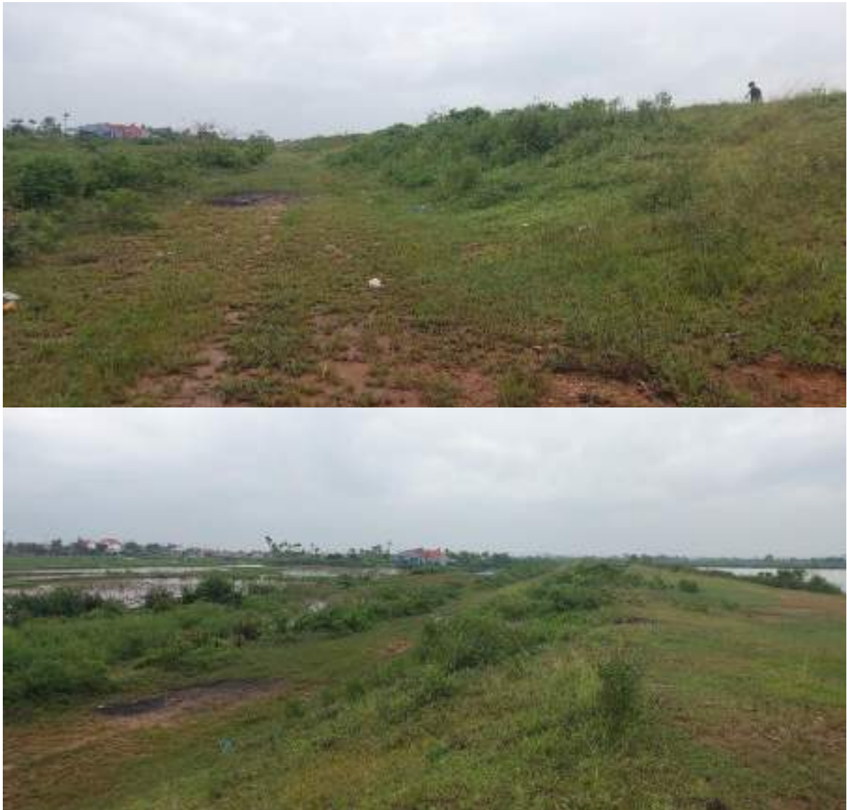
Hình 3.1. Hiện trạng tuyến đê tả Văn Úc
