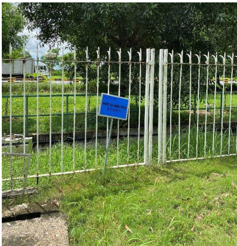
Hình 3. 6. Vị trí điểm xả nước mưa nhà máy hiện tại
