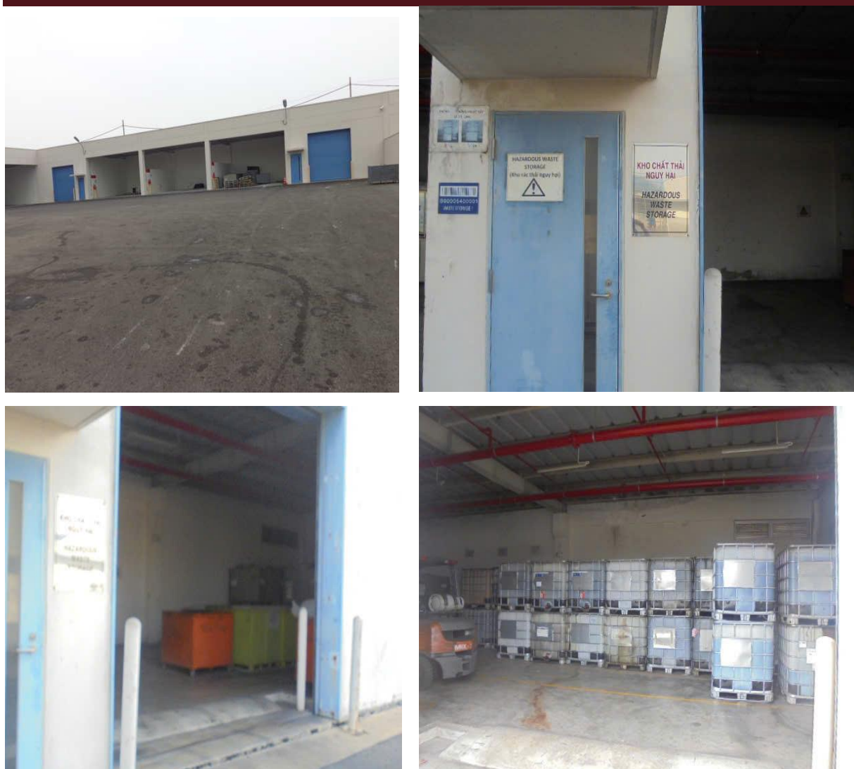
Hình 3. 27. Một số hình ảnh kho chứa CTNH tại kho rác chung hiện hữu của cơ sở
