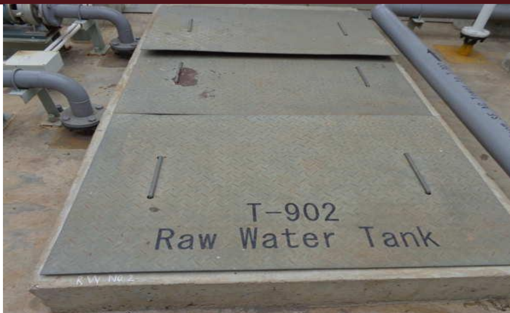
Hình 3. 8. Hình ảnh tank nước thô
