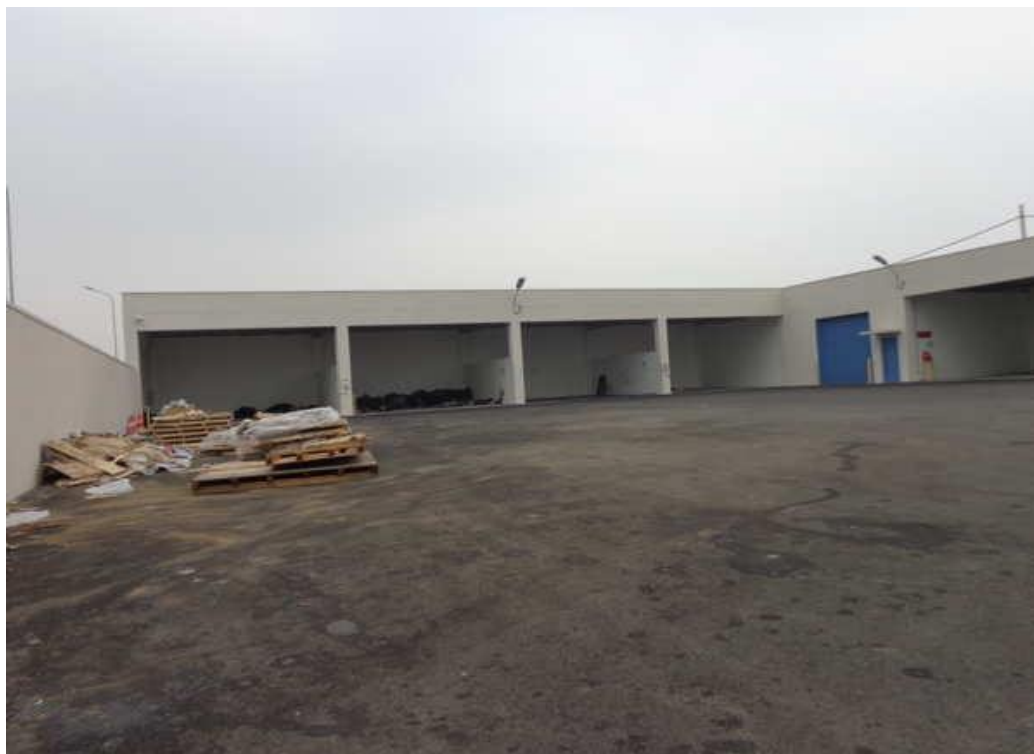
Hình 3. 26. Hình ảnh kho chứa chất thải sinh hoạt của Công ty
