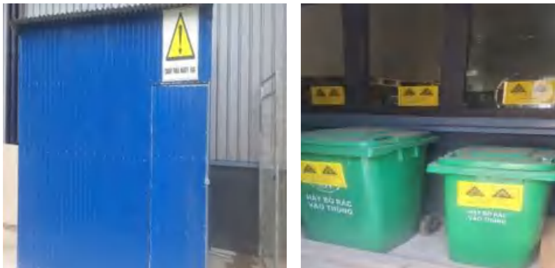
Hình 3. 16. Hình ảnh kho chứa CTNH tại địa điểm 1
