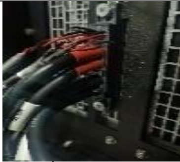
Lắp pin dẫn điện
