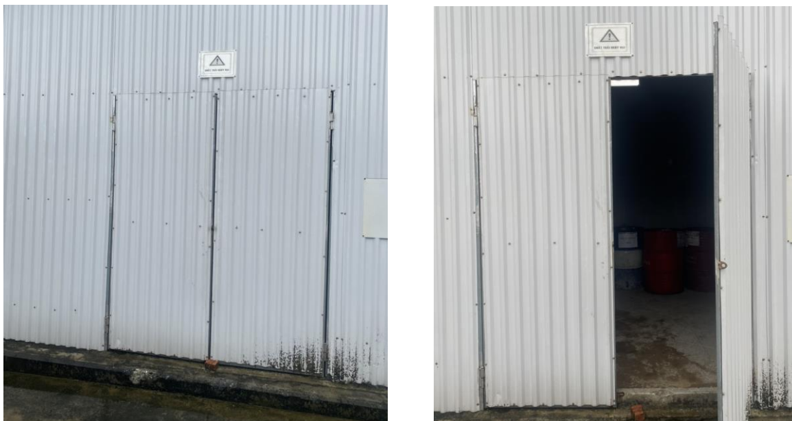
Hình 3.22. Kho chứa chất thải nguy hại của Nhà máy
