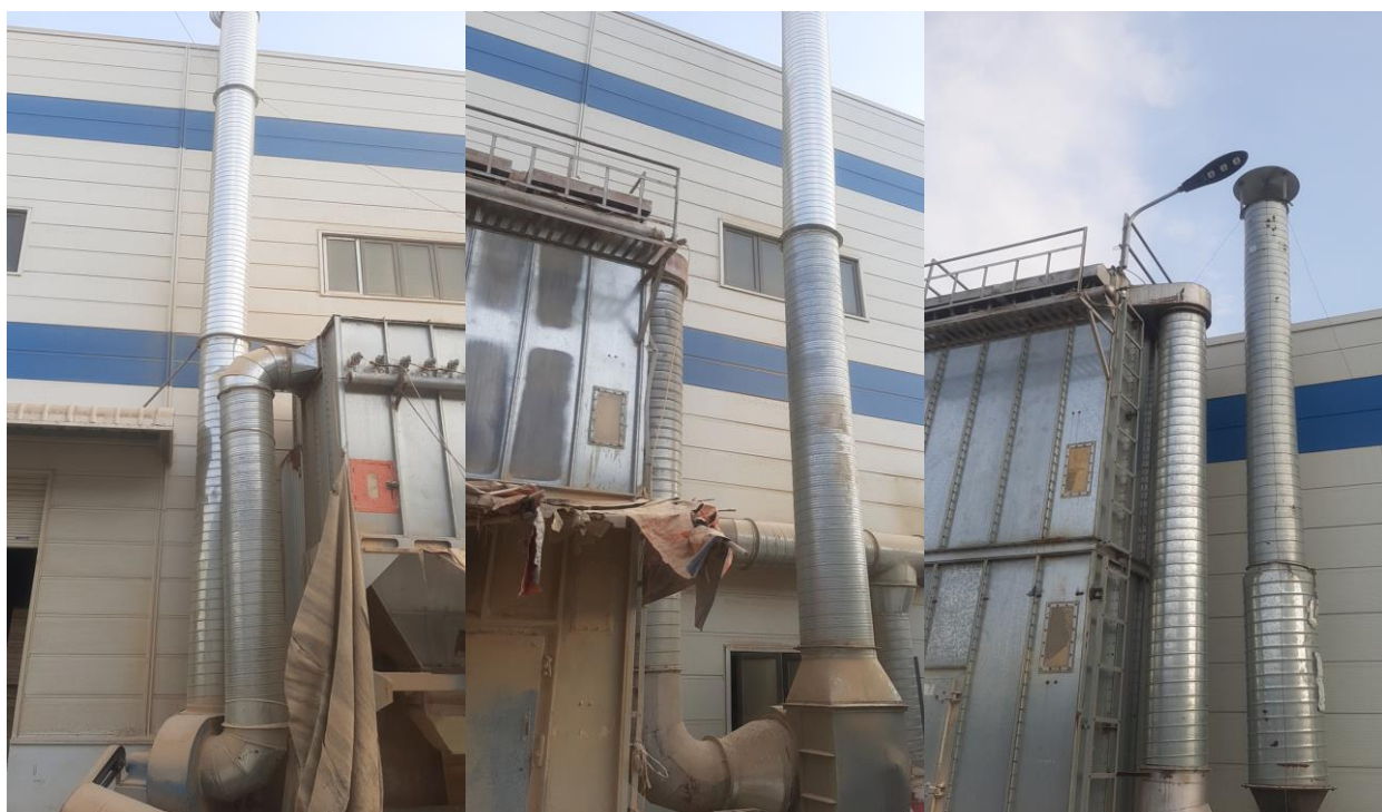
Hình 3.11. Hình ảnh ống khói khí thải hệ thống xử lý bụi khu vực chà nhám, đánh bóng
