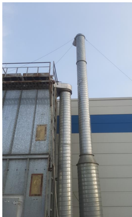
Hình 3.13. Hình ảnh hệ thống xử lý khí thải khu vực làm sạch bề mặt trước khi sơn và khu vực đánh ráp bề mặt giữa 2 lần sơn lót
