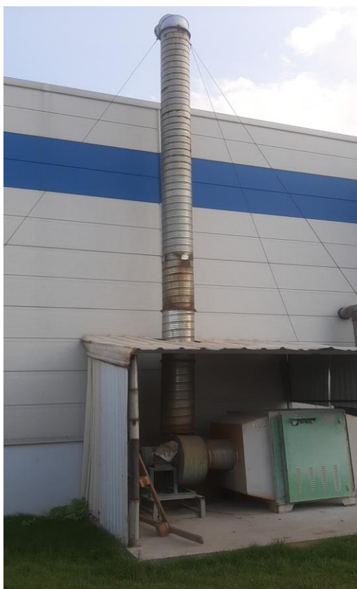
Hình 3.13. Hình ảnh hệ thống xử lý khí thải khu vực làm sạch bề mặt trước khi sơn và khu vực đánh ráp bề mặt giữa 2 lần sơn lót
