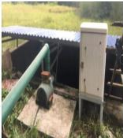
Bể thu gom
