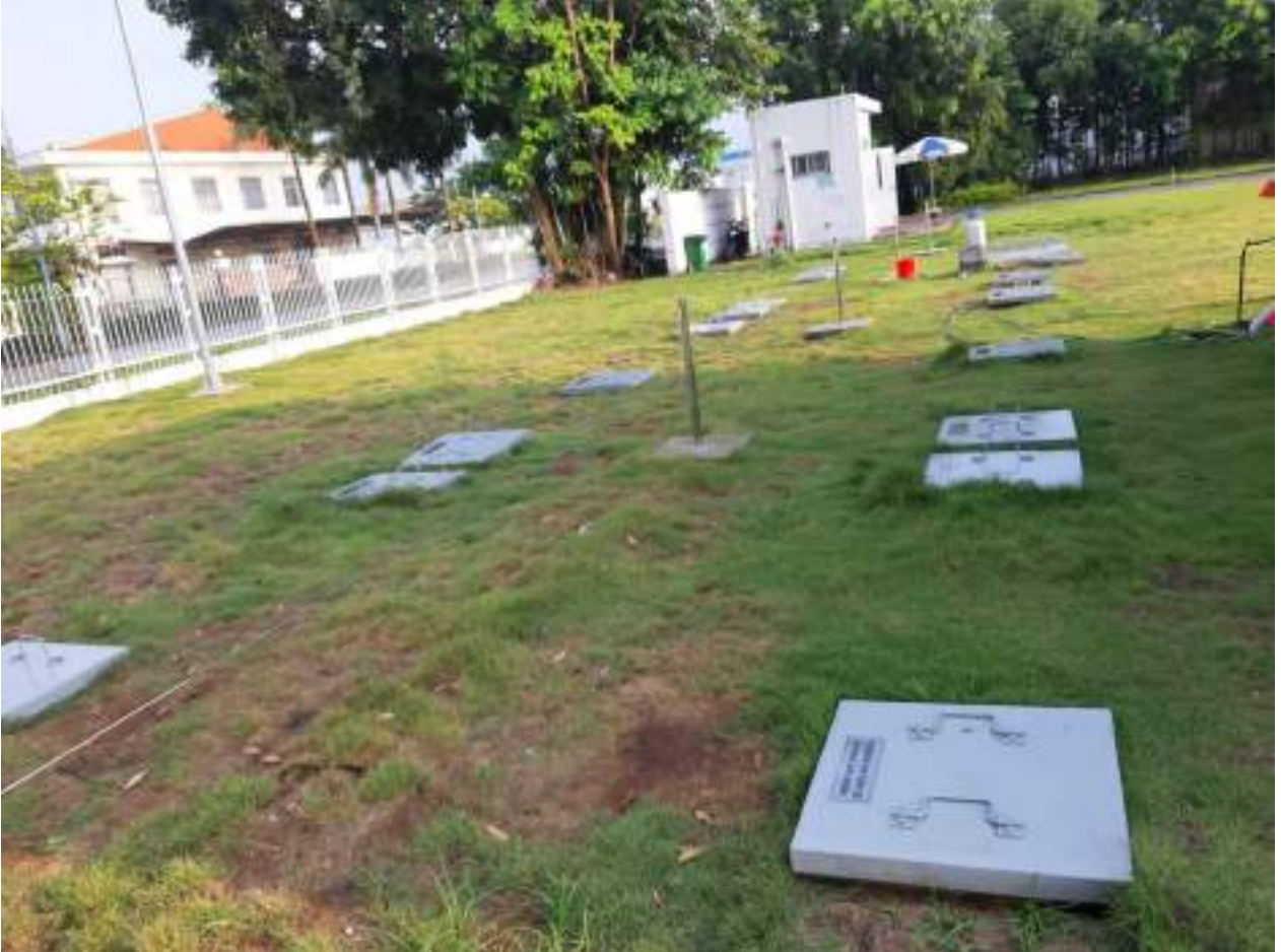
Hình 18. Hình ảnh thực tế hệ thống xử lý nước thải 120m 3 /ngđ
