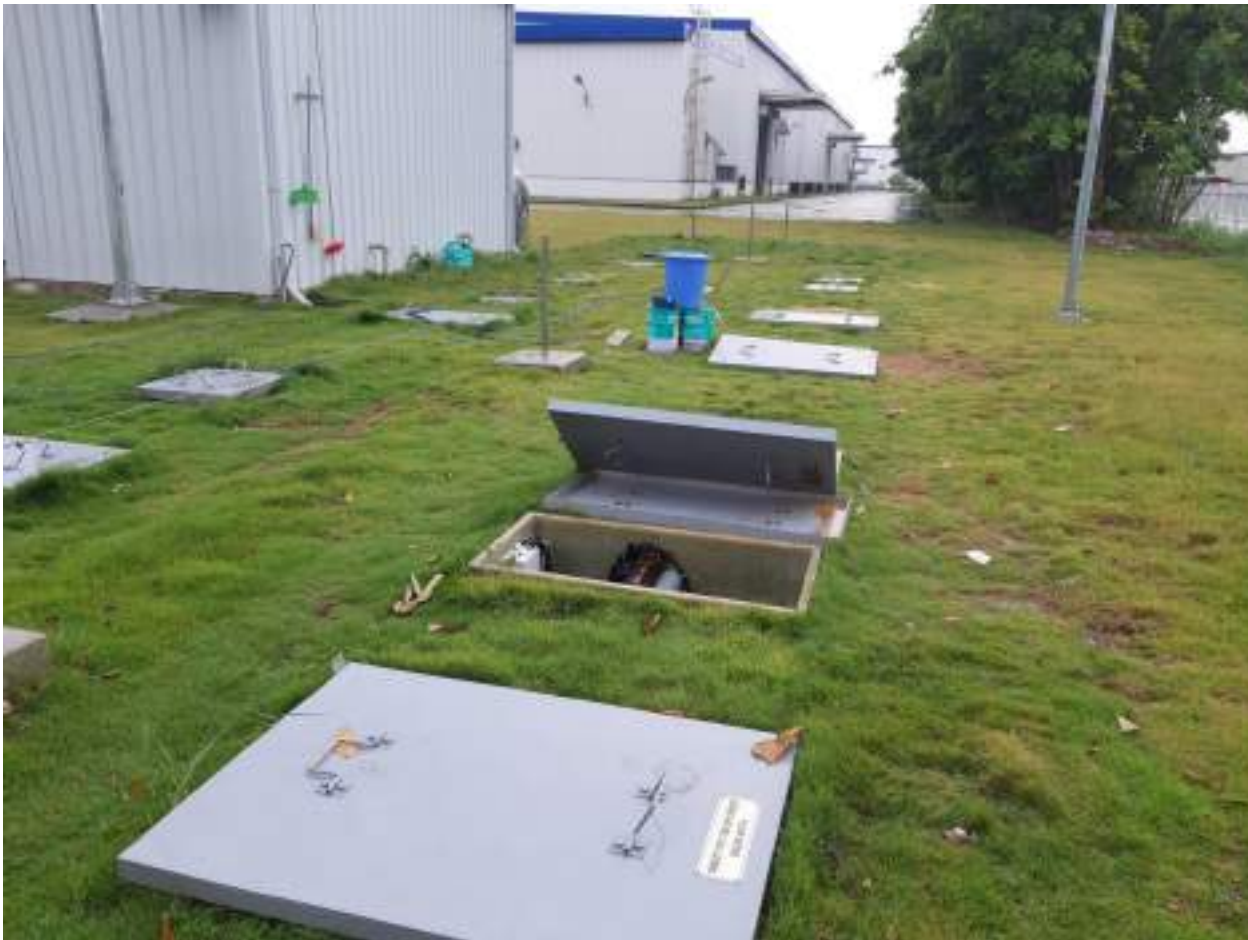
Hình 20. Hình ảnh thực tế hệ thống xử lý nước thải 152m 3 /ngđ
