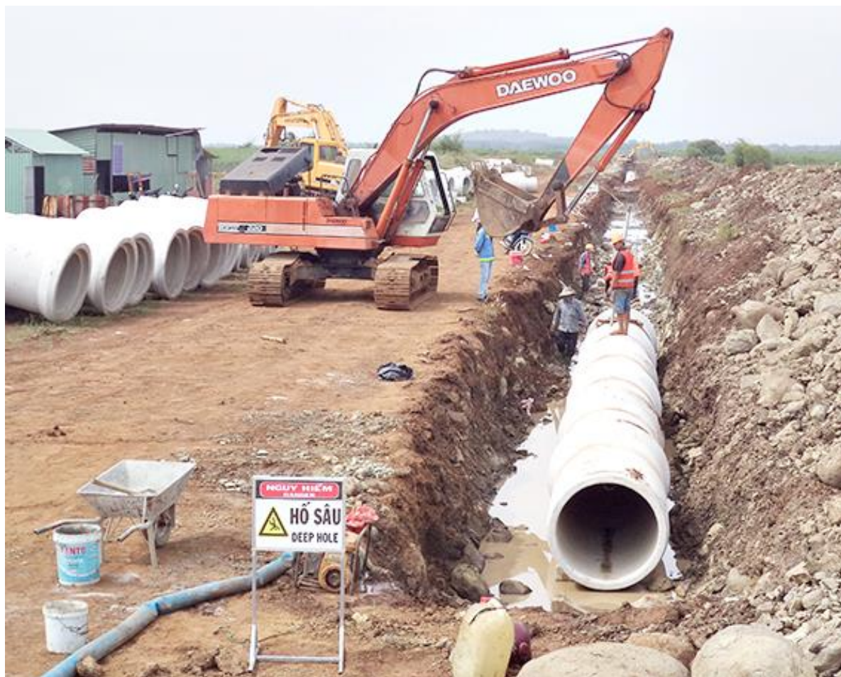
Hình 3. 3. Hoạt động thi công hệ thống thoát nước
