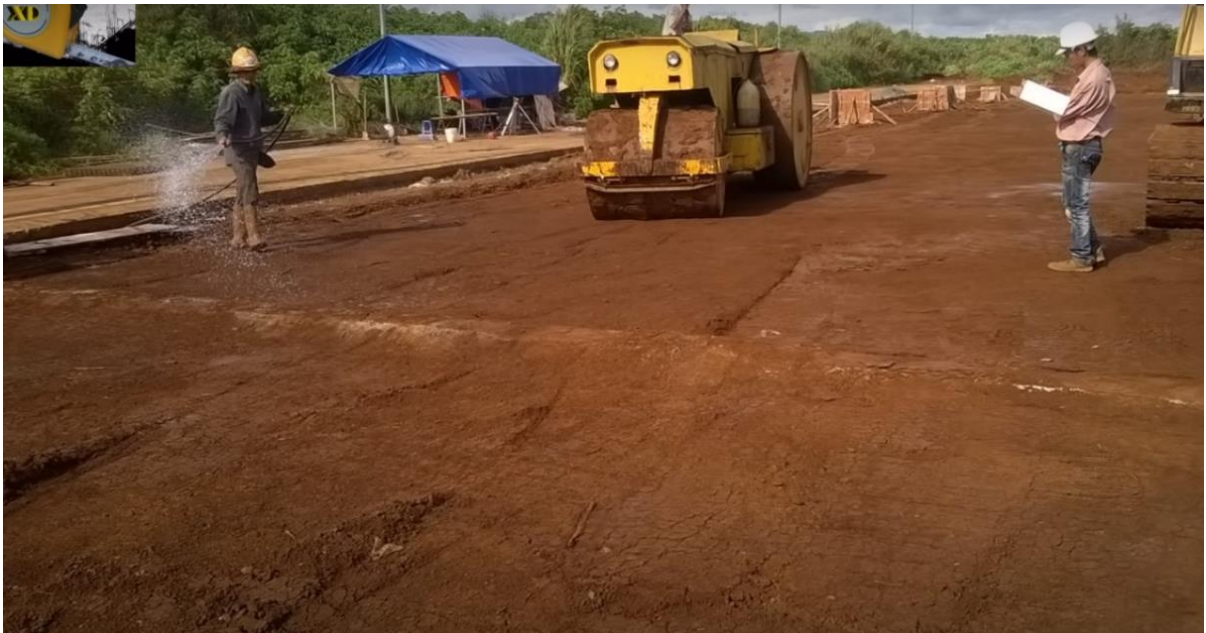
Hình 3. 1. Tưới ẩm cát trong quá trình san nền
