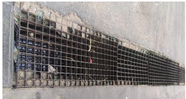
Hình 4.3. Rãnh, ga thoát nước mưa dọc tuyến đường nội bộ chính
