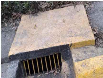
Hình 4.3. Rãnh, ga thoát nước mưa dọc tuyến đường nội bộ chính
