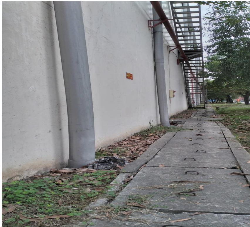
Hình 4.2. Hệ thống thu nước mưa tầng mái
