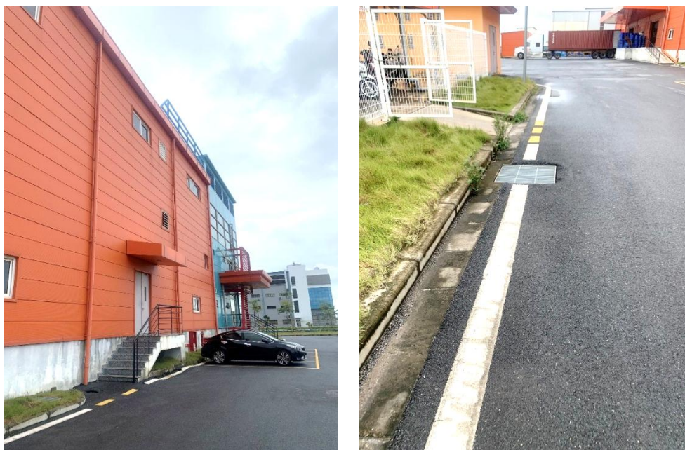
Hình 3. 3. Hệ thống ống dẫn nước mưa mái và hố ga thu nước mưa
