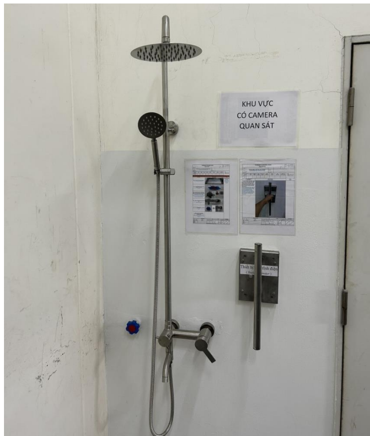
Hình 18. Thiết bị khử tĩnh điện và vòi rửa tại kho hoá chất
