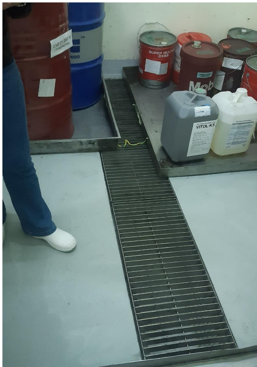
Hình 21. Rãnh thu gom hoá chất khi xảy ra sự cố tràn đổ
