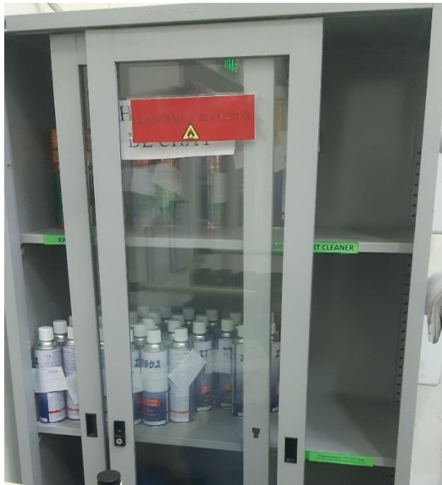
Hình 20. Tủ đựng hoá chất dễ cháy trong kho
