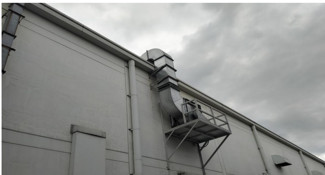
Hình 3.14. Hình ảnh hệ thống thu gom, dẫn khí thải sau xử lý của phòng in
