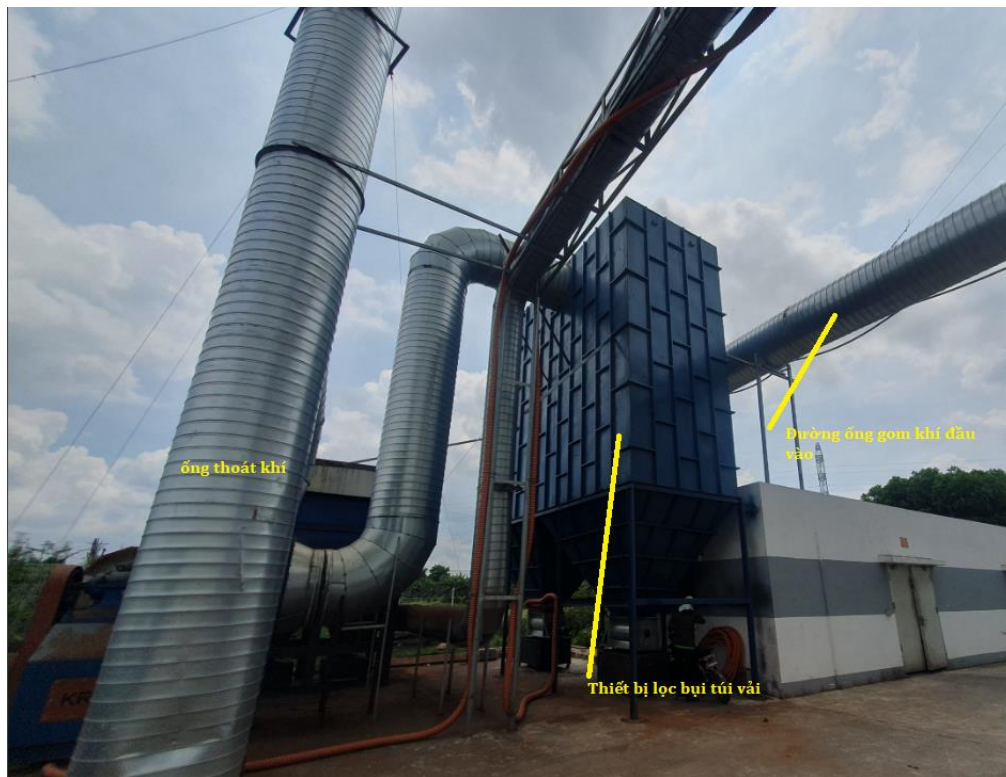
Hình 4.6. Hệ thống xử lý bụi khu vực gia công tinh tạo đĩa phanh thành phẩm tại xưởng 1 (minh họa tại Công ty Yuekai cùng loại hình)
