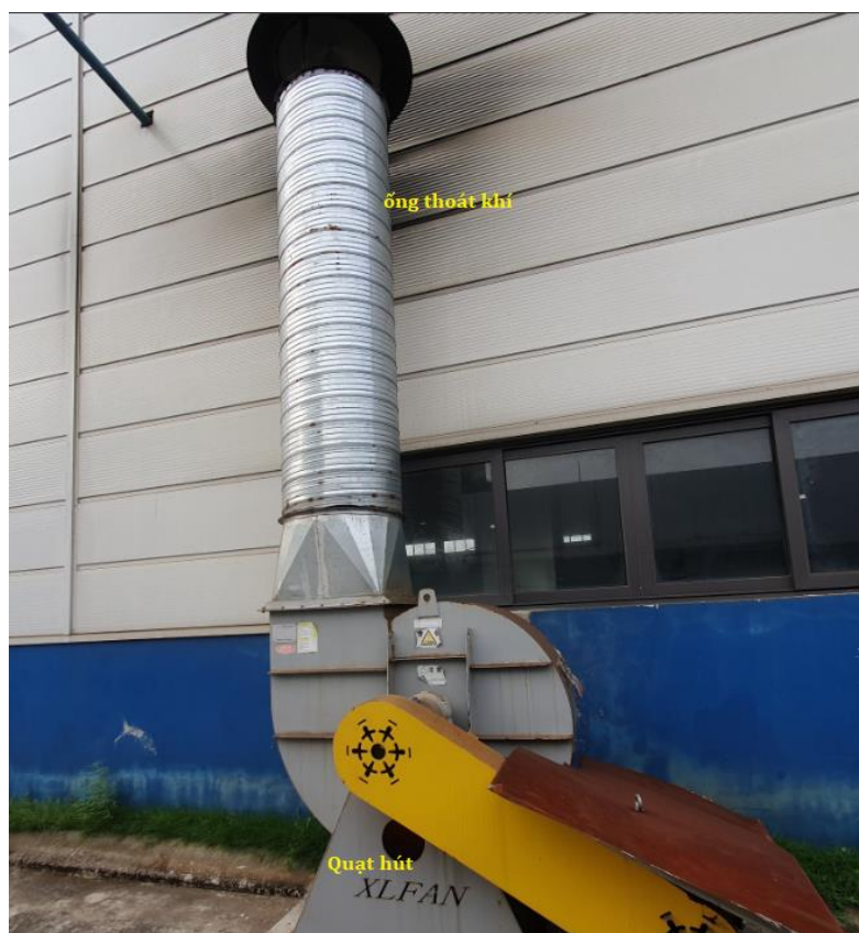
Hình 4.4. Hệ thống xử lý bụi, khí thải chuyên sơn, sấy đĩa phanh tại xưởng 1 (minh họa tại Công ty Yuekai cùng loại hình)
