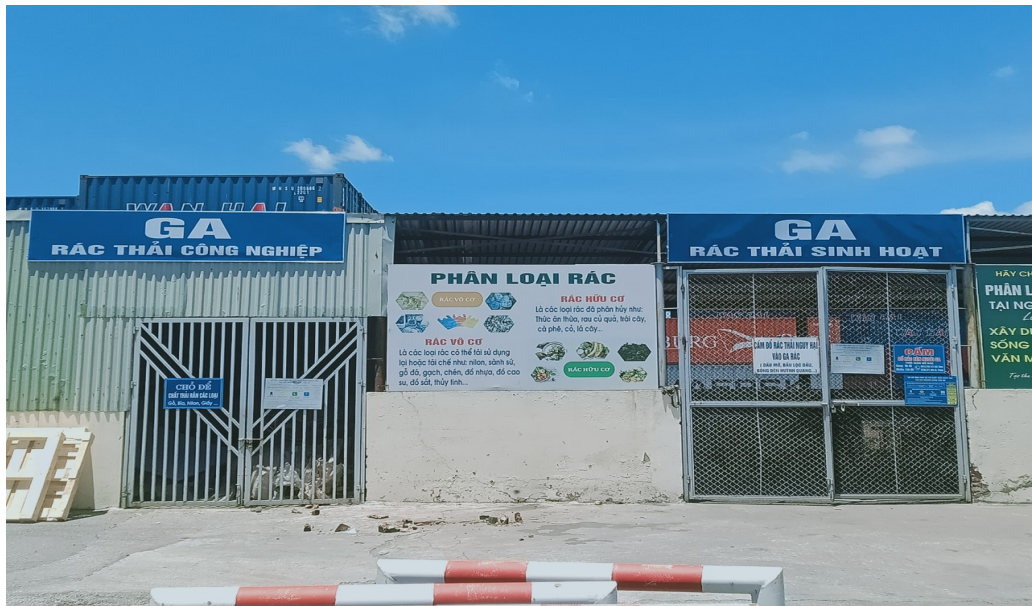
Hình 3.9. Hình ảnh kho chứa chất thải rắn sinh hoạt và kho chất thải rắn công nghiệp
