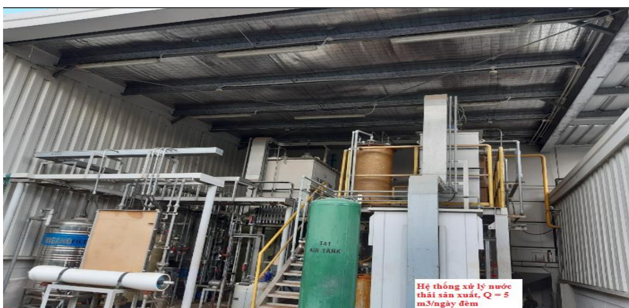
Hình 3.6. Hệ thống xử lý nước thải sản xuất, công suất 5\text{m}^3/\text{ngày} đêm
