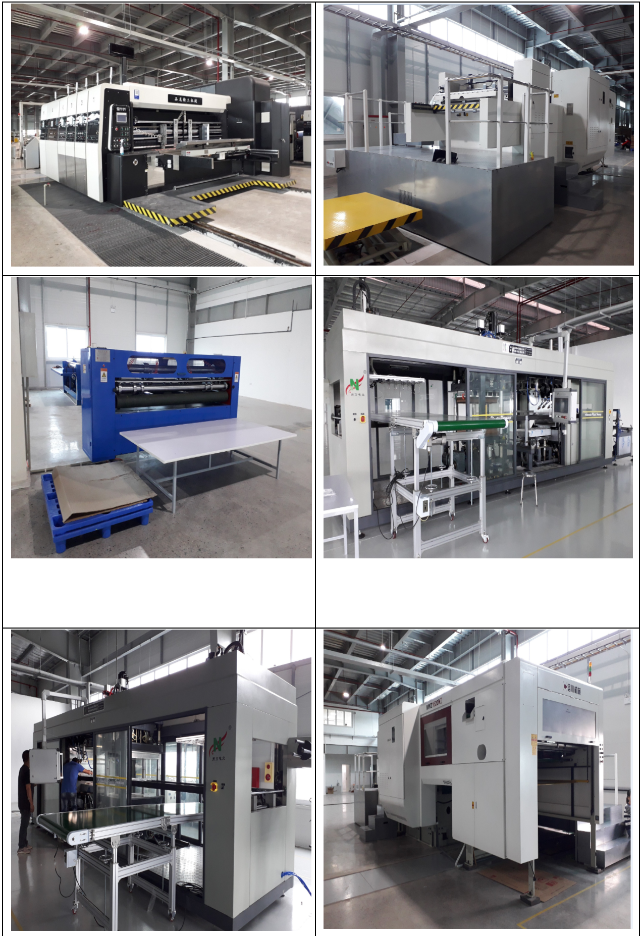
Hình 9. Một số hình ảnh máy móc đã được lắp đặt tại nhà xưởng 1
