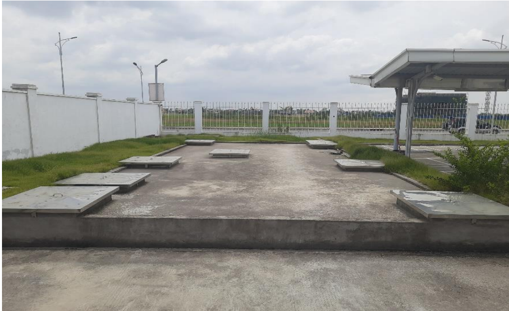
Hình 3. 5. Bể thu gom nước thải
