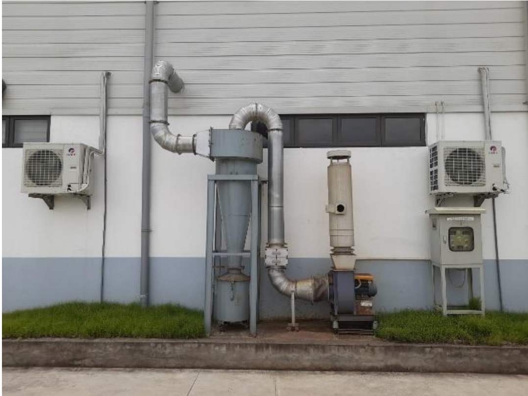
Hình 3. 12. Hệ thống xử lý bụi kim loại khu vực mài
