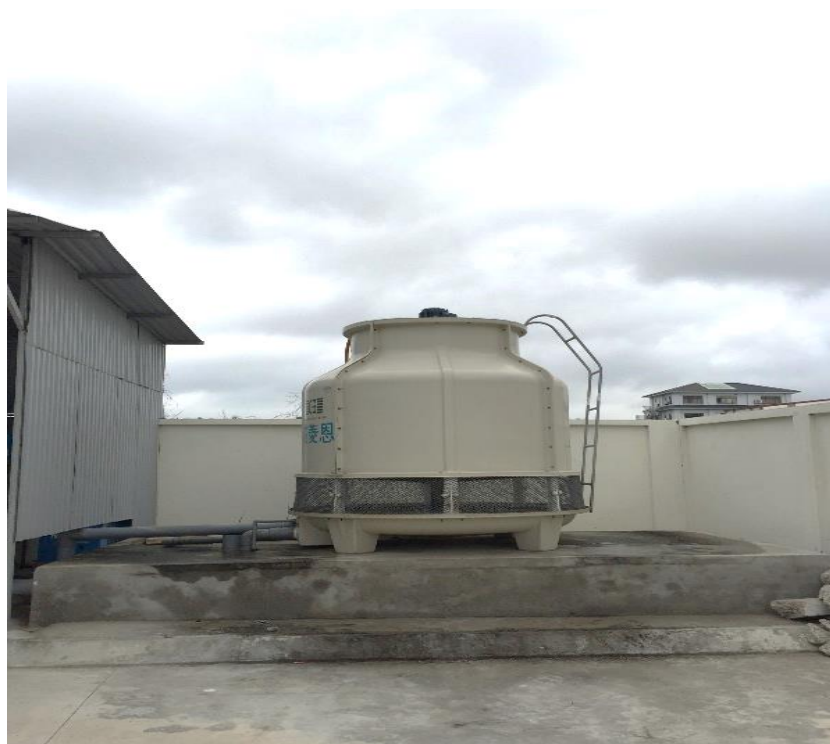
Hình 8. Tháp giải nhiệt làm mát
