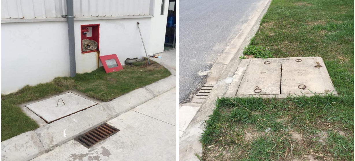
Hình 4. Hồ ga thu gom nước mưa chảy tràn
