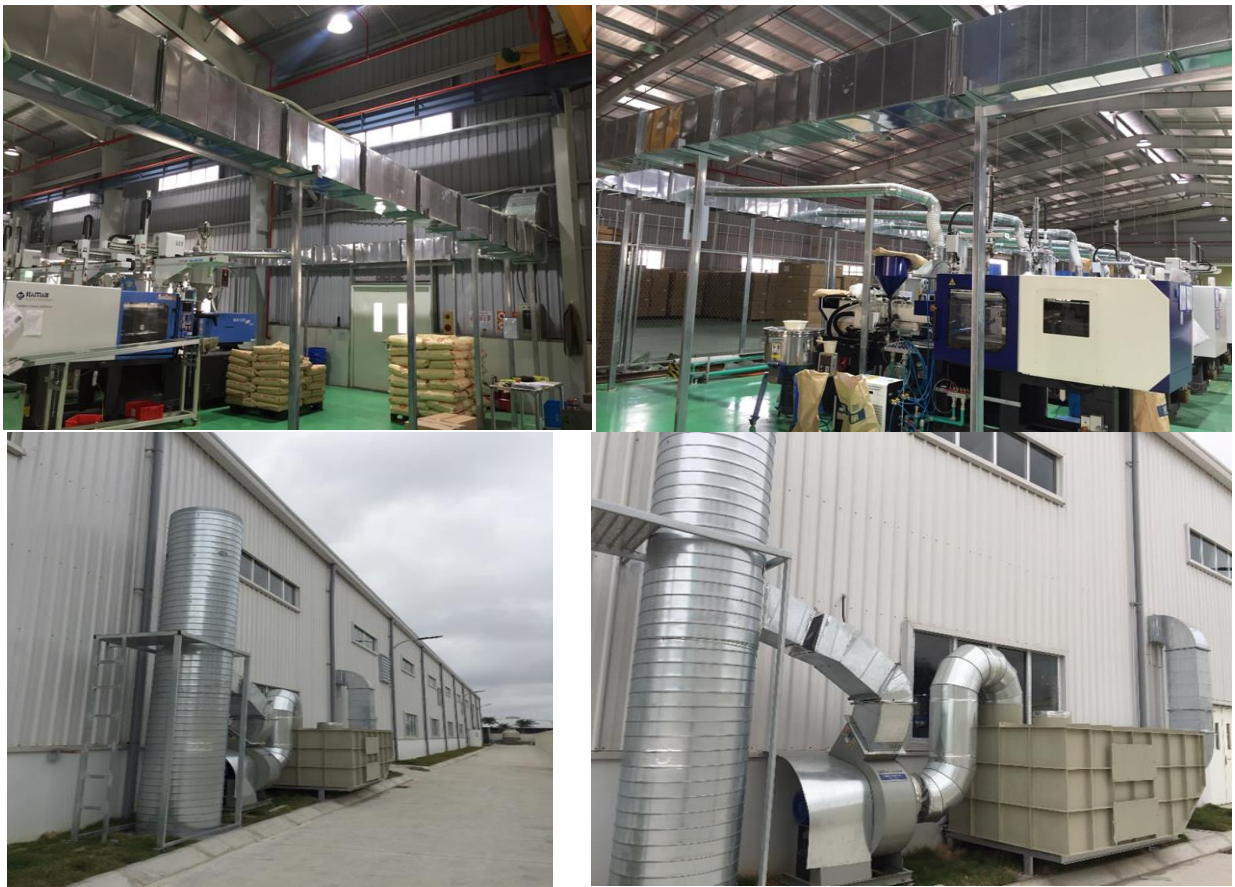
Hình 12. Hệ thống xử lý khí thải khu vực đúc ép nhựa
