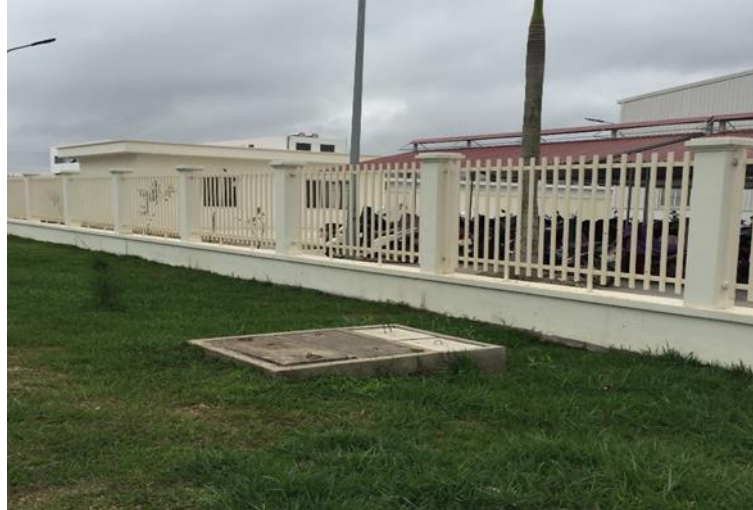
Hình 6. Điểm đầu nối nước thải
