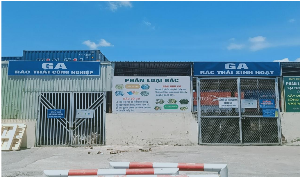
Hình 3.8. Hình ảnh kho chứa chất thải rắn sinh hoạt và kho chất thải rắn công nghiệp
