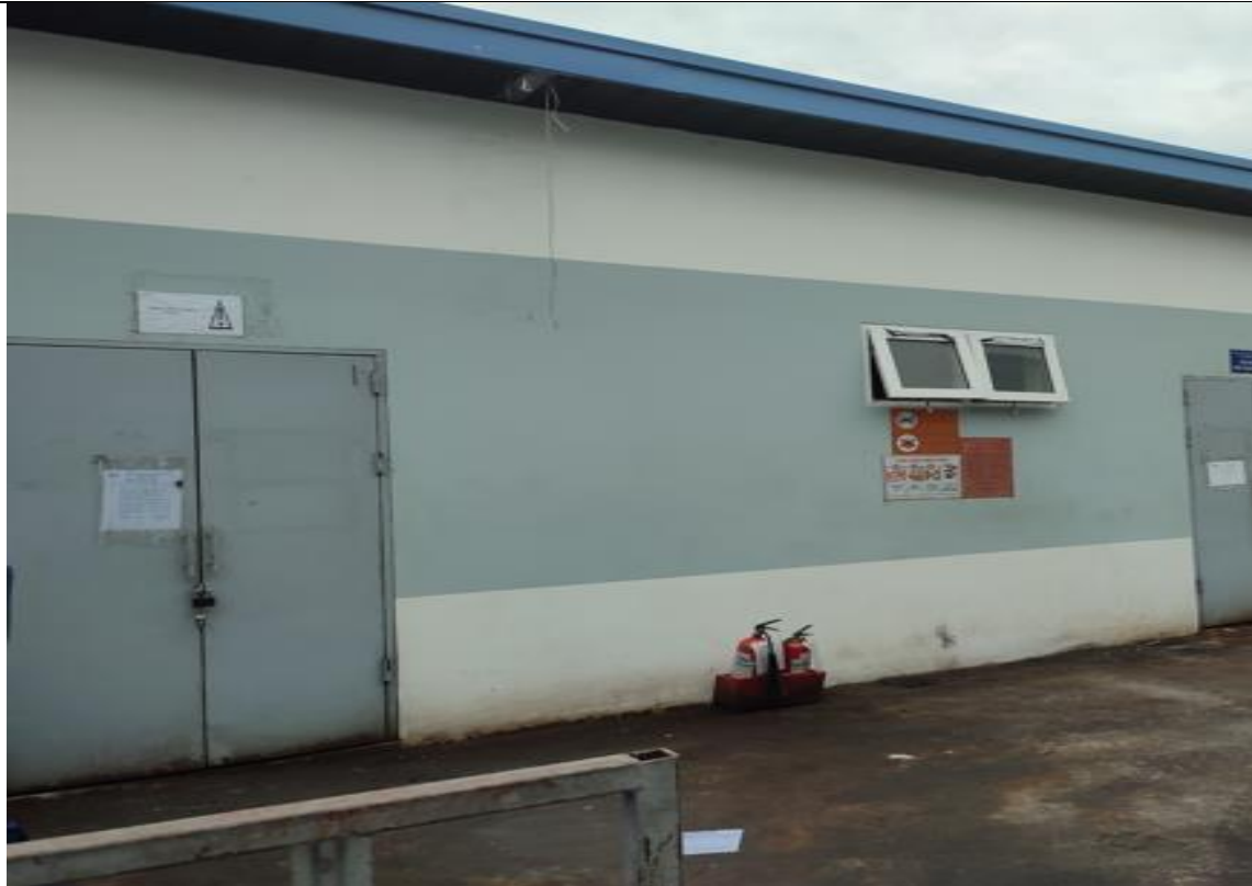
Hình 3.7. Hình ảnh kho chứa hóa chất của Công ty
