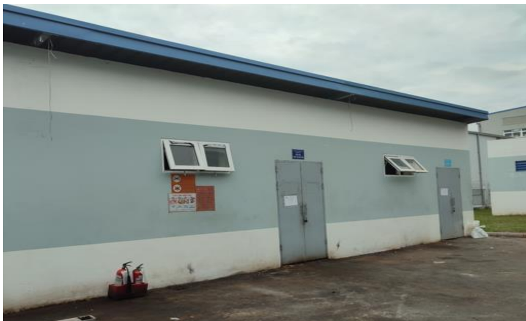
Hình 3.12. Hình ảnh kho chứa chất thải nguy hại của Công ty
