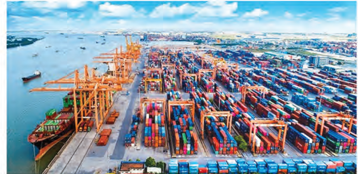
Hải Phòng hiện có các khu vực cảng biển, logistics được bố trí tập trung cùng sự kết nối hạ tầng giao thông và công nghiệp có tính liên kết cao
