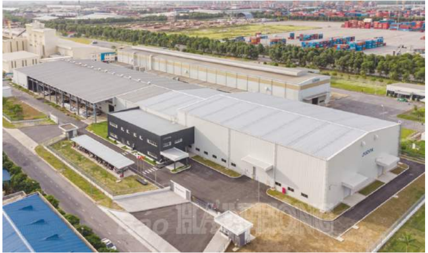
Khu nhà xưởng mới được xây dựng của Công ty TNHH Jyuichiya Việt Nam tại KCN DEEP C Đình Vũ
